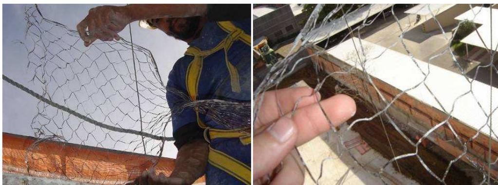
Do ponto de vista mecânico, a desvantagem dessas chapas expandidas reside no fato de que, solicitadas na direção da expansão, existe a tendência de rasgamento do trecho onde os cordões estão ainda ligados, na outra direção existe a tendência de fechamento da malha, que não ocorre se houver argamassa ali confinada, mas que pode acabar provocando fissuração acompanhando o desenho das malhas.
