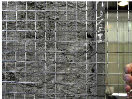
Entre as principais vantagens técnicas das telas com malha quadrada eletrossoldada, se encontra a uniformidade no diâmetro e espaçamento dos fios. No travamento da fissura, por ter módulo de deformação maior (maior rigidez) tela soldada tem atuação mais efetiva que outras telas mais deformáveis. E a orientação dos fios, em direções ortogonais, permite o seu posicionamento nas direções dos esforços principais (CHAMELETE, 1999).
