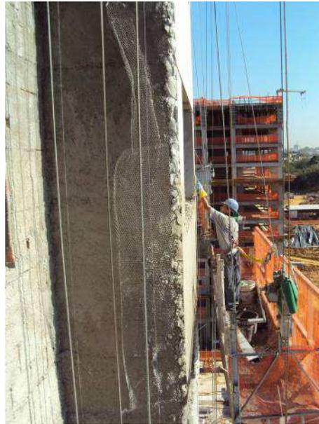
Uma das principais limitações das telas voltadas para aplicação em revestimento reside no fato delas usualmente serem fornecidas em rolos. Segundo Silva (2012) isto dificulta o seu posicionamento no local recomendado, sua fixação na estrutura, e ainda possibilita a ocorrência de reflexão da argamassa. As telas fornecidas em rolo deverão ser cortadas e aplainadas antes de serem encaminhadas para a aplicação nas fachadas (CEOTTO *et al.*, 2005).
