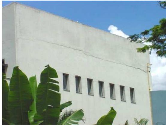
As fissuras desenvolvidas em argamassas de revestimento, sem fissuração na base, de acordo com Thomaz (1989), são causadas por solicitações térmicas e, sobretudo, por tensões de retração da argamassa elevadas. Em havendo restrições às solicitações decorrentes da resistência à tração e do módulo de deformação da argamassa, as chances para surgimento de fissuras são ainda maiores.
