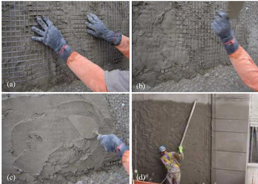
Embora haja recomendação do uso da tela imersa no meio da camada do revestimento, supõe-se de modo similar ao verificado nas estruturas de concreto armado, que a armadura no compósito cimentício promoverá ganho mais apreciável no desempenho quanto ao controle de fissuração quando disposto no banzo tracionado da estrutura (PFEIL, 1989; LEONHARDT e MÖNNING, 2007; NAWY, 2008; WIGHT e MACGREGOR, 2012).
