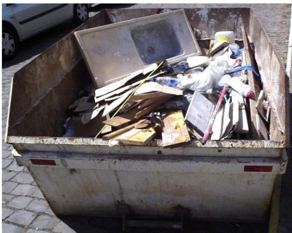
Figura 06 – Flagrante de disposição de resíduos não inertes em caçamba coletora de RCD.
