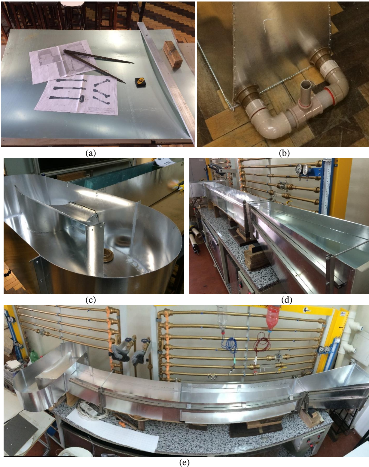
Figura B.3 Imagens do processo construtivo do canal hidráulico; (a) Marcação das chapas para serem cortadas; (b) Conexões de PVC; (c) Bocal de entrada de água do canal; (d) Teste hidrostático após termino da construção; (e) Disposição final do canal hidráulico da bancada do laboratório LAEFT.
