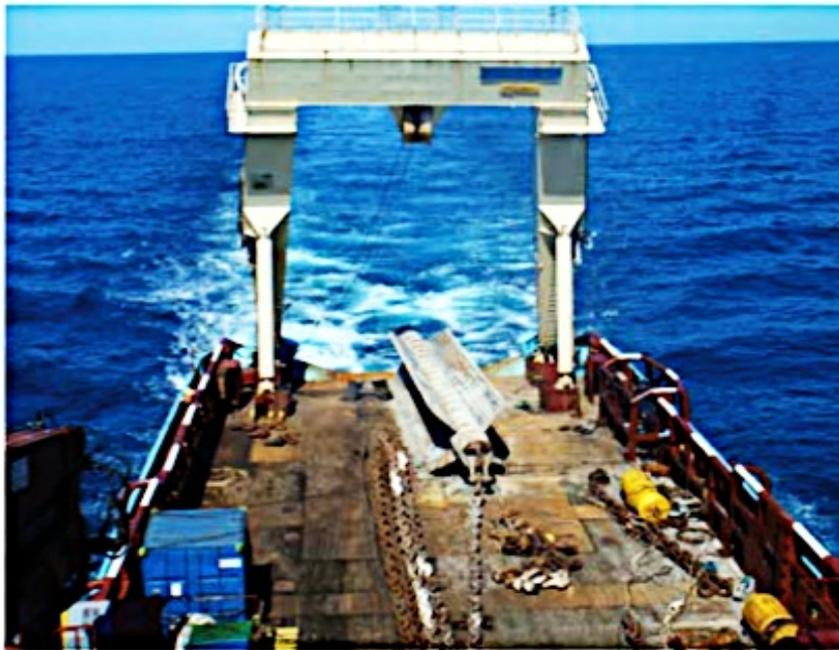
Figura 2.9 – Foto de um navio durante o procedimento de instalação de estaca torpedo (Henriques Jr. *et al*, 2010).
