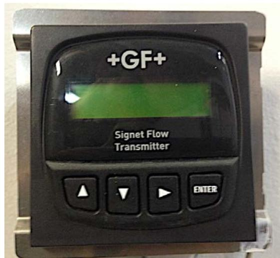
Figura 3.15 – Transmissor e visualizador de vazão *Signet 8850-1*.
