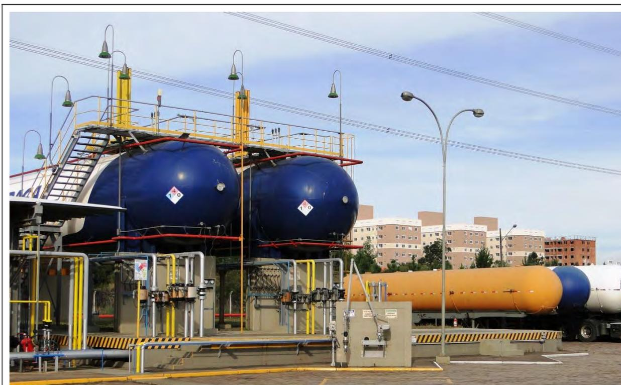
Figura 56: Canoas. Fotografia obtida do pátio de engarrafadora de gás liquefeito de petróleo, situado no distrito industrial de gases e combustíveis, ao lado do qual estão sendo construídas habitações. Em primeiro plano dois tanques de 60.000 litros de gás, e ao lado direito, carretas de transporte de gás. Aos fundos os prédios habitacionais em fase final de construção. Na parte superior da ilustração podem ser observados cabos da linha de transmissão que passa entre ambos.
