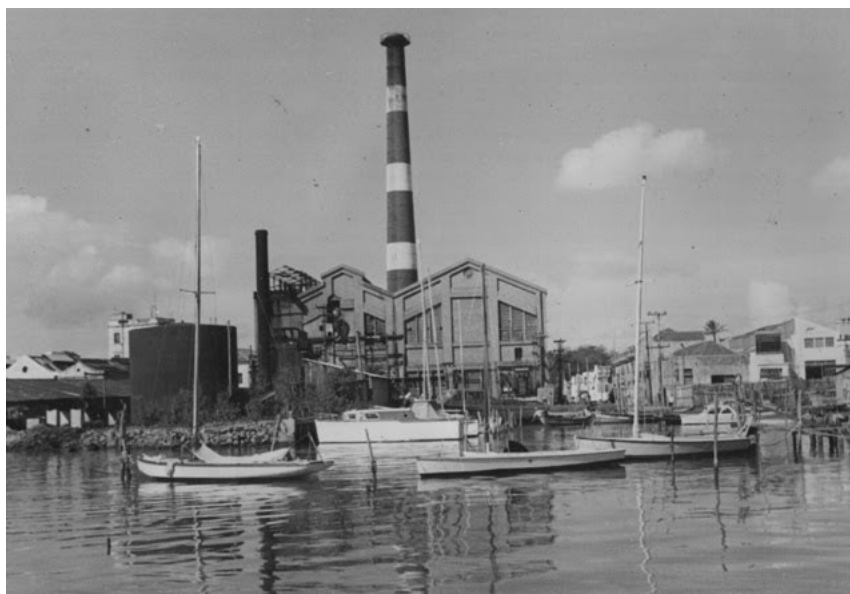
Figura 18. Fotografia da Usina na década de 30. Disponível em: < http://www.skyscrapercity.com/showthread.php?t=1327521&page=1 > Acesso em jul. 2016.
