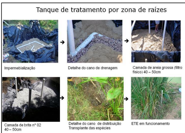
Figura 63. Passos para construção do tanque com sistema de zona de raízes. Fonte: Copetti (2010). Obs.: A camada de areia grossa deve ser substituída por brita zero para evitar entupimento.
