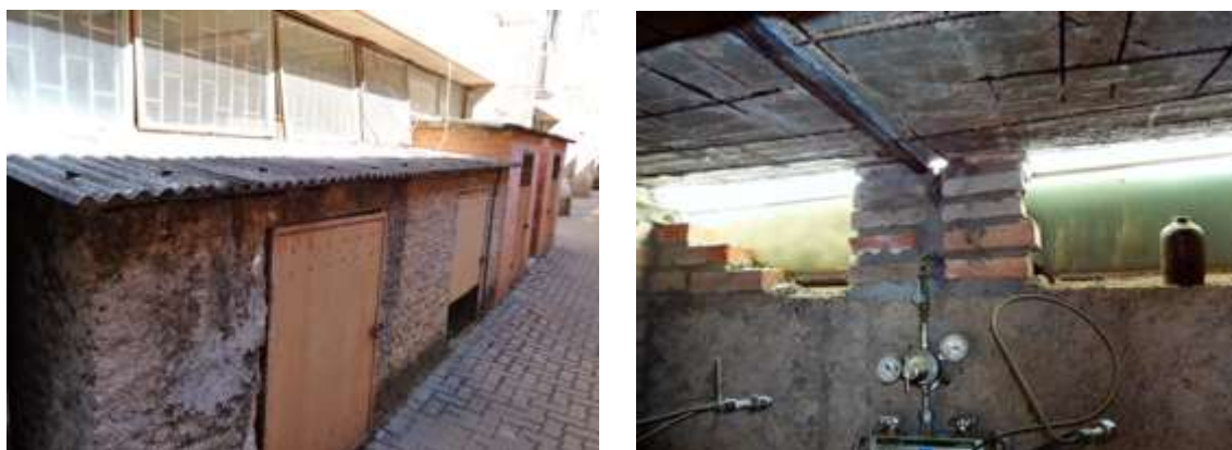
Figura 4.7: Casa de gases e linha de gases do LABSAN: antigas e inadequadas.
