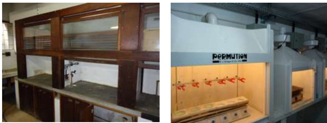
Figura 4.5: Capelas de exaustão. Antes e depois da reforma.
