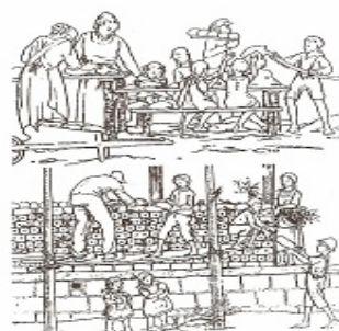
Ilustração de técnica do "pió-de-barro" (Minke, 1994, p.96).
