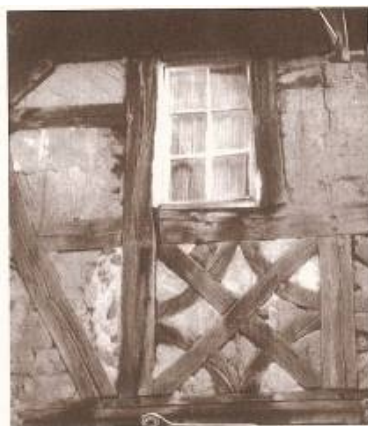
Ilustração do uso de pedra bruta, aparelhada e barro numa casa do Hunsrück (Freckmann, 2002, p.36).
