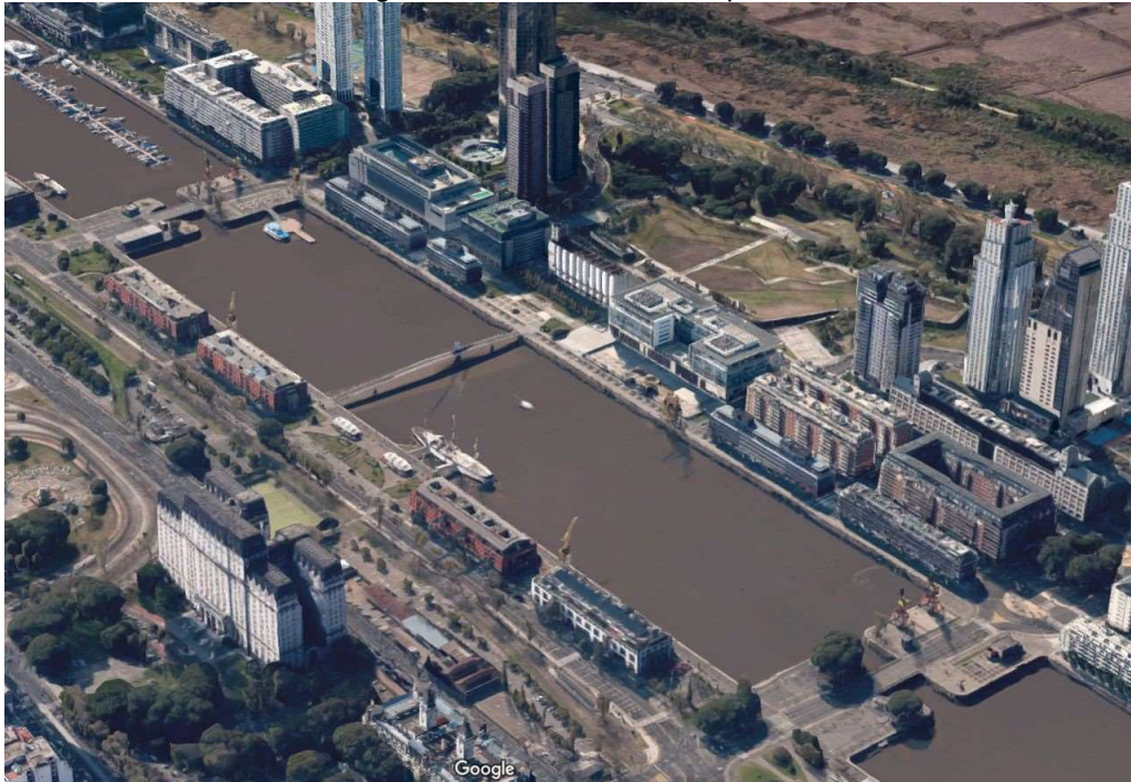
Figura 46: Vista aérea do Dique 3
