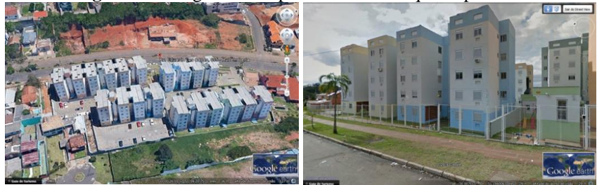
Fonte: Google Earth e Google Street View.
