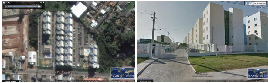
Fonte: Google Earth e Google Street View.
