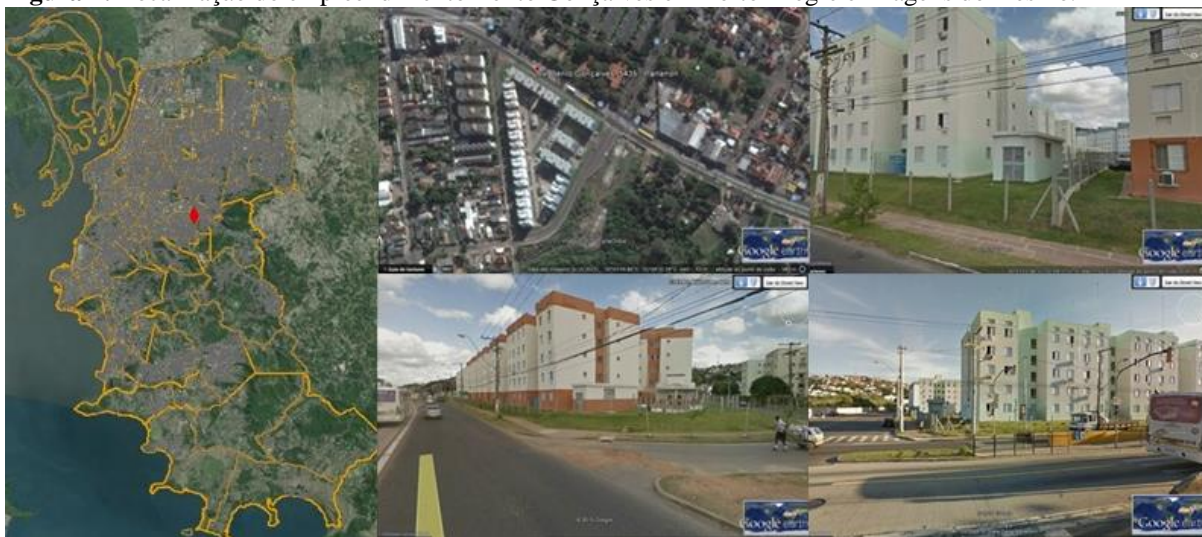
Figura 7: Localização do empreendimento Bento Gonçalves em Porto Alegre e imagens do mesmo.
