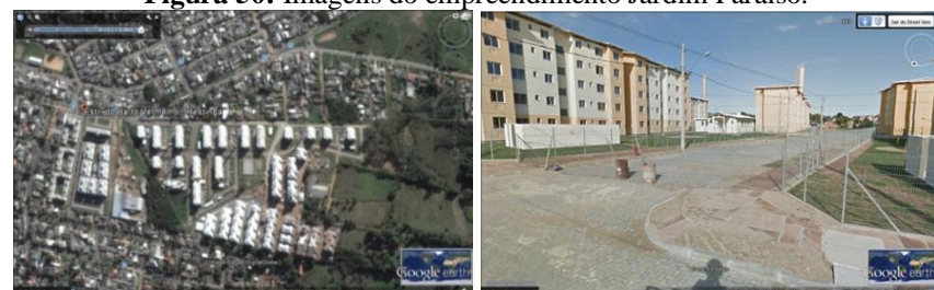
Figura 50: Imagens do empreendimento Jardim Paraíso.
