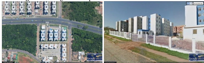
Fonte: Google Earth e Google Street View.
