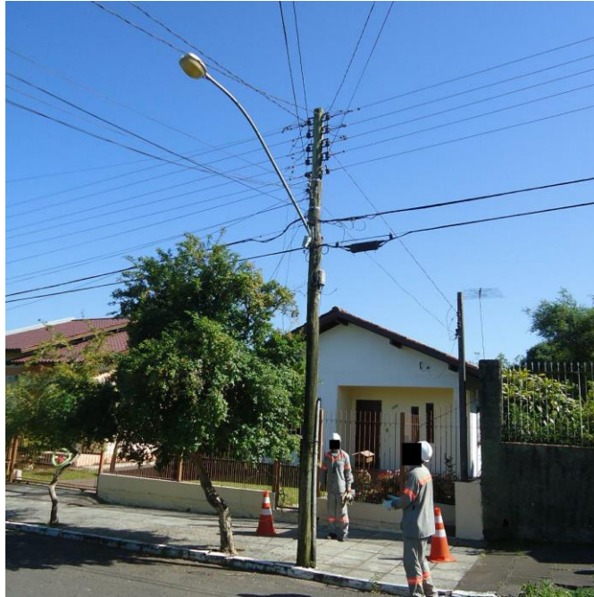
Figura 3 – Ambiente de Trabalho do Eletricista 1
