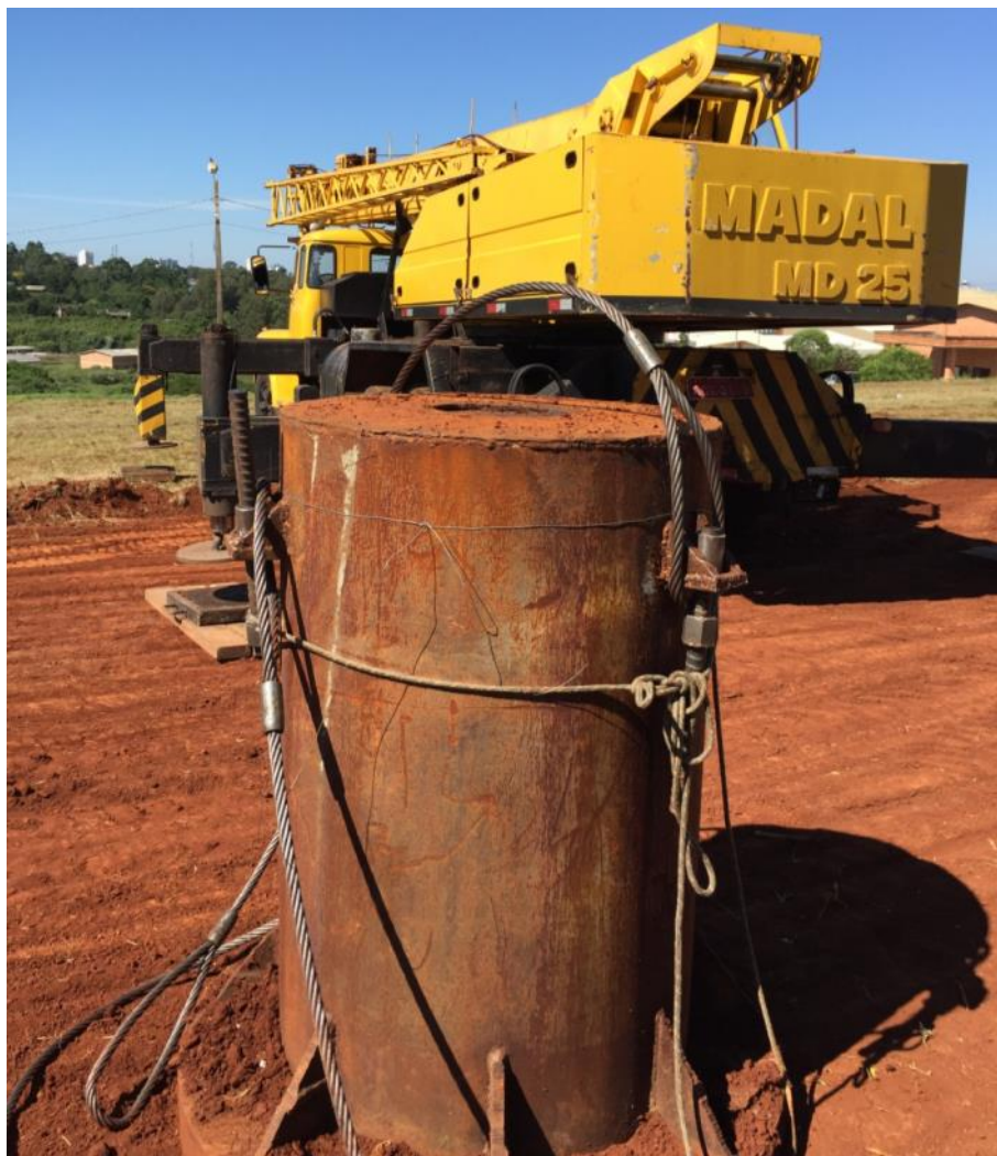
Figura 3.4 – Detalhe da amarração dos cabos de aço às talas metálicas.
