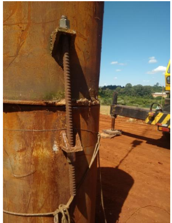
Figura 3.3 – Blocos combinados e detalhe da barra de união
