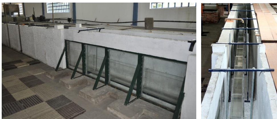
Figura 12. Canal longo de alvenaria e janela de observação.
