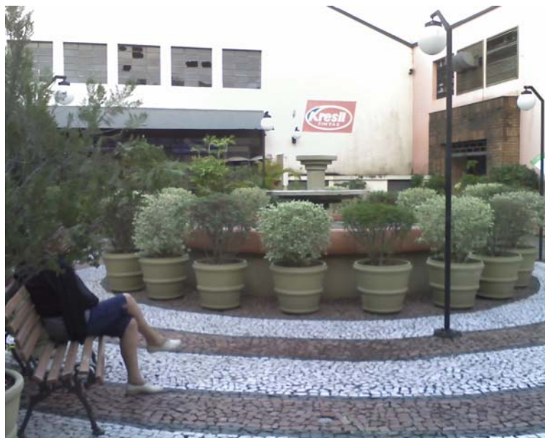
Fotografia 17 – Pátio interno degradado.
