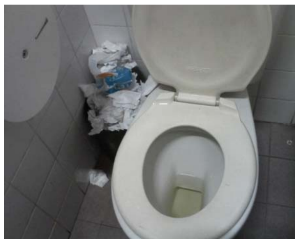
Fotografia 22 – O estado de limpeza do sanitário Fonte: Material de campo
