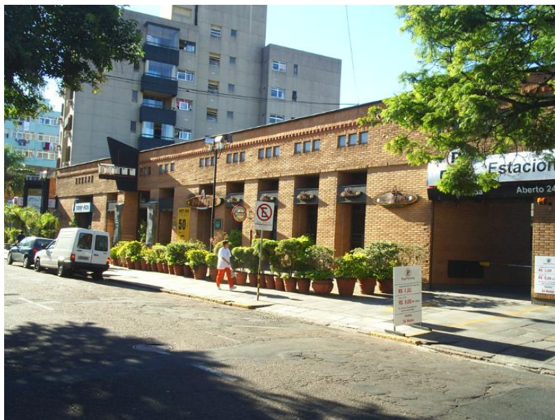
Fotografia 05 – Obstáculos na fachada.
