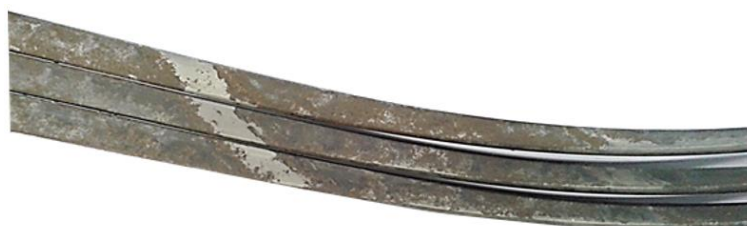
Figura 100 – Alinhamento da corrosão nos gaps da fita anti-atrito
