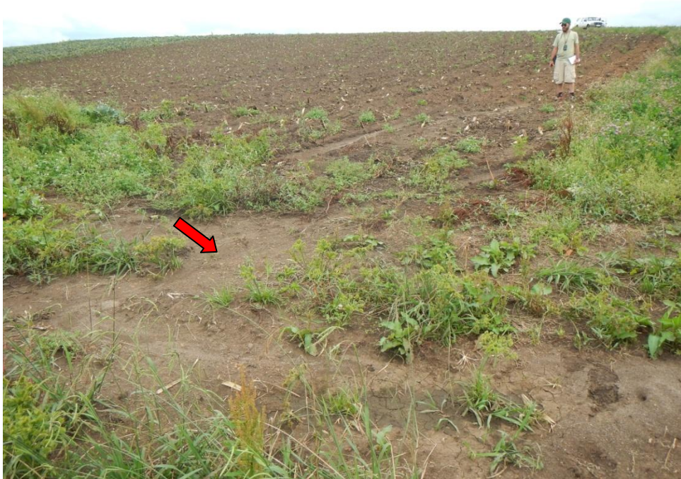
Figura 5.15 - Área de acúmulo de sedimentos. (foto: Clódis Andrades Fº, 17/01/2015)
