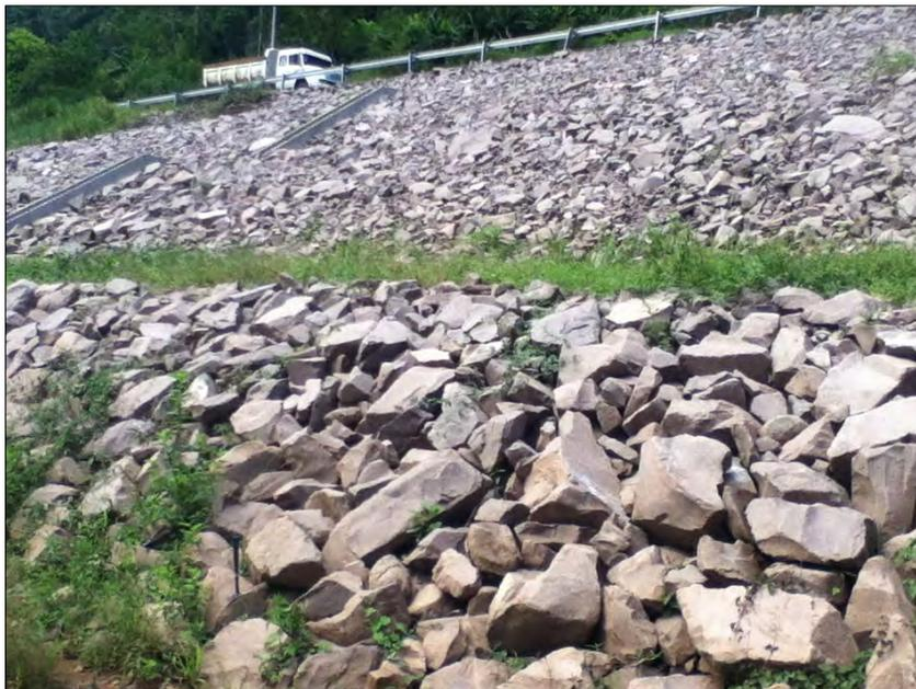
**Figura 25.** Foto registrada do enrocamento que reconformou o talude do quilômetro 13+500 da ERS-431. Fonte: Dados da Pesquisa.
