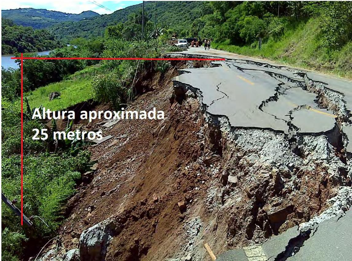
**Figura 4.** Foto de detalhe da ruptura circular ocorrida no quilômetro 13+500 da ERS-431, de acordo com os padrões de rupturas circulares definidos por OLIVEIRA E BRITO (1998).
