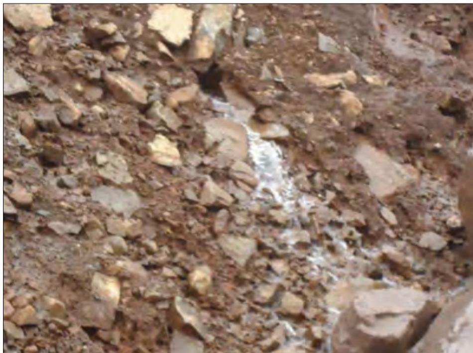
**Figura 23.** Foto registrada no talude à jusante do quilômetro 13+500 da ERS-431, na qual evidencia-se a ocorrência de vertência de água no talude rodoviário em camada de deposição coluvionar e consequente carreamento de sedimentos finos de fração silte e argila. Fonte: Dados da Pesquisa.
