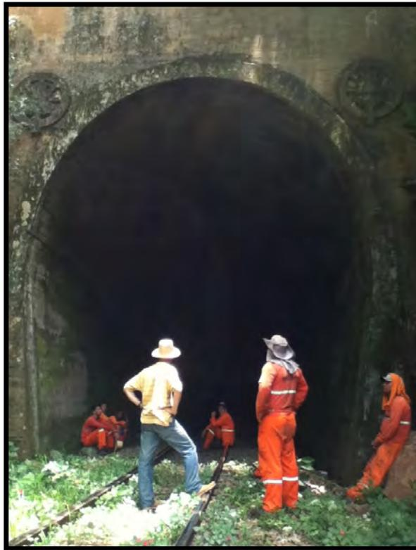
**Figura 7.** Foto do túnel ferroviário situado à montante da ERS-431, onde foi possível averiguar a atitude de camadas de derrames basálticos concordantes com o leito do Rio das Antas (atitudes comprovadas pelos testemunhos de sondagens mistas). Fonte: Dados da Pesquisa.
