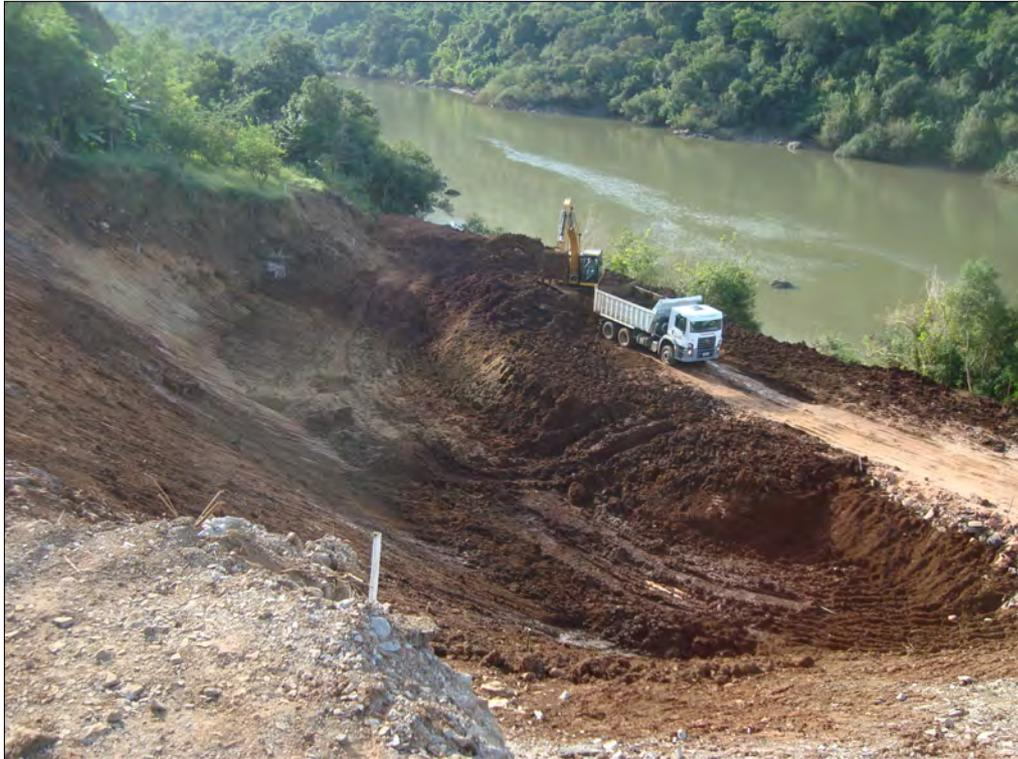
**Figura 24.** Foto registrada da escavação do talude à jusante do quilômetro 13+500 da ERS-431, em 20/05/2014 (Magna Engenharia, 2014),
