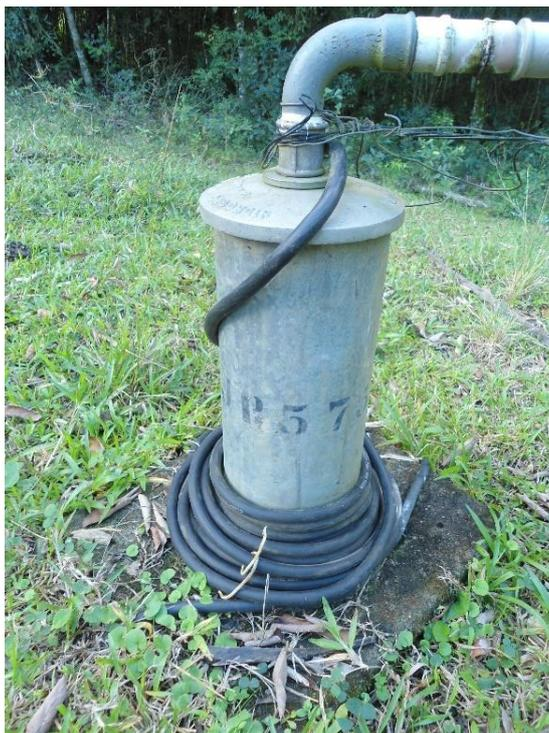
*Figura 13: Poço tubular profundo inventariado e cadastrado pela CPRM*
