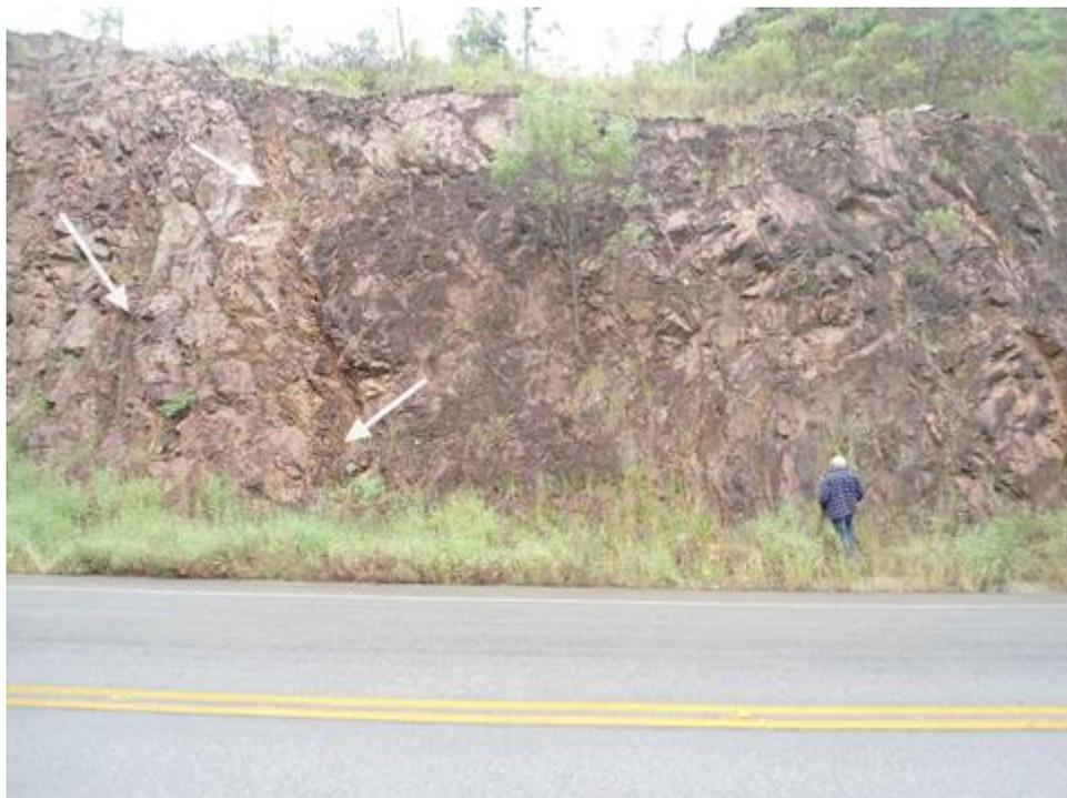
*Figura 12: Afloramento de corte de estrada altamente fraturado, indicando a percolação de água.*
