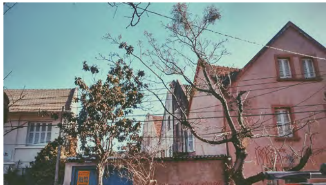
VISTA LATERAL DO CONDOMÍNIO, EVIDENCIANDO O ALINHAMENTO DE FUNDOS
