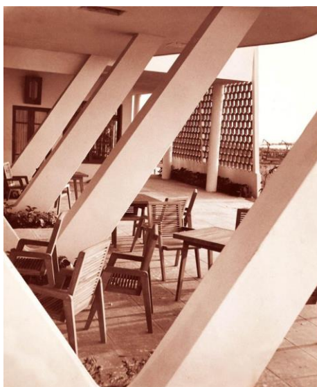
Figura 94: Avarandado com pilares em “V” sustentando a laje curva. Fonte: BERTOLUCI, 2011, p. 45
