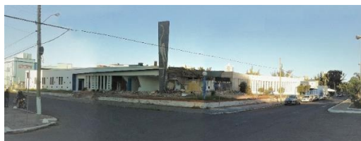
Figura 56: Demolição parcial em abril de 2013. Fonte: Autora
