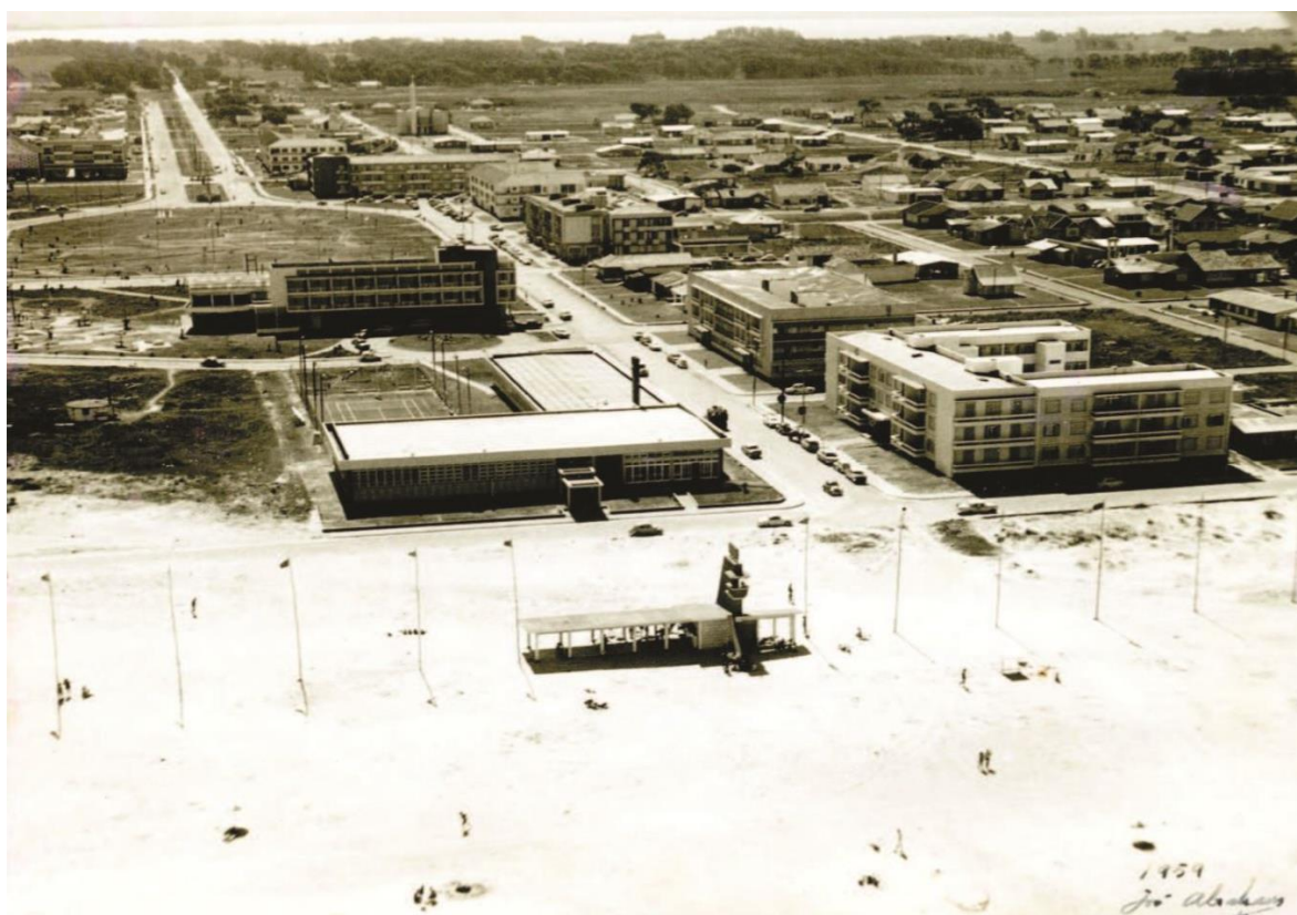
Figura 108: Beira Mar de Atlântida com os três edifícios da Avenida Central: mirante, SABA e Hotel Atlântida. Foto posterior a 1968. Fonte: RODRIGUES, 2016, p.120
