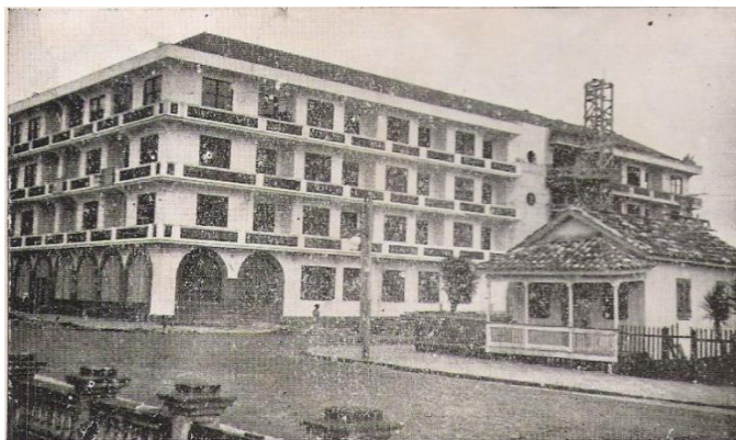
Figura 157: Edifício SAPT em dezembro de 1950.
