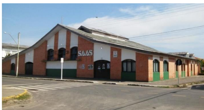
Figura 143: Sede da SAAS nas condições atuais. Fonte: Tiago Dalla Chiesa
