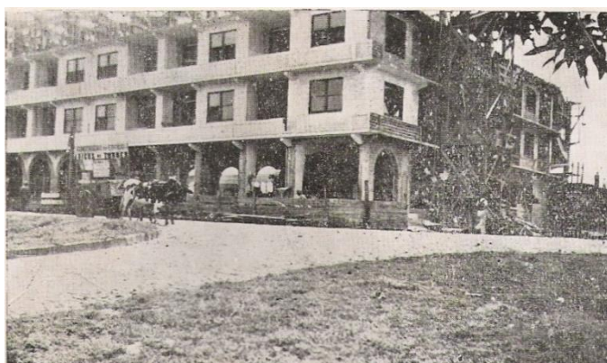
Figura 154: Parte do edifício já construído em novembro de 1949. Fonte: Relatório da Sociedade Amigos da Praia de Torres, fev. 1952. Museu Três Torres.
