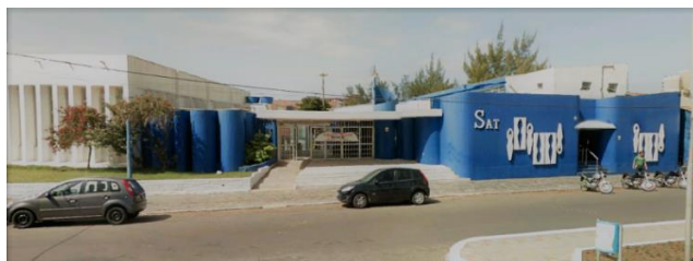
Figura 55: Segunda ampliação - Academia de ginástica no pavimento acima do volume azul, 1980. Fonte: Autora, 2013.
