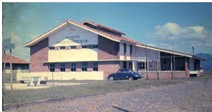
Figura 137: Projeto parcialmente construído e inaugurado em 1960. Fonte: Tiago Dalla Chiesa
