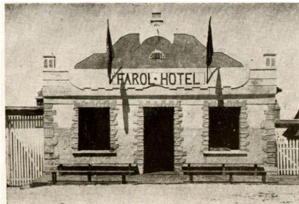
Figura 15: Fachada do Hotel Farol em Torres, 1934. Fonte: Revista A Gaivota, 1934
