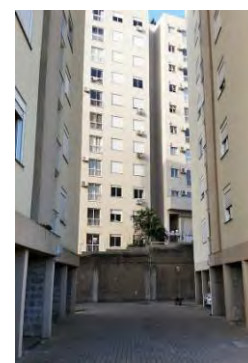
Figura 65 – Área entre blocos
