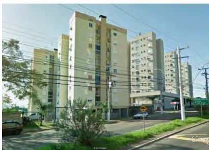
Figura 61 – Vista 1 – vista frontal do conjunto. Fonte: Google, 2015.
