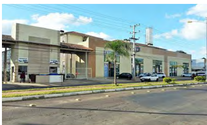
Figura 48 – Vista 1 – portaria e salas comerciais
