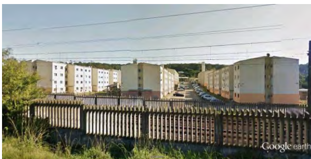
Figura 43 – Vista 1 – muro do trem urbano. Fonte: Google, 2015.
