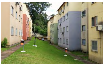
Figura 101 – Área entre blocos
