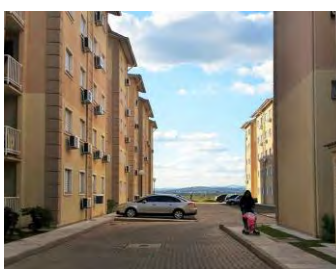
Figura 96 – Rua e calçada
