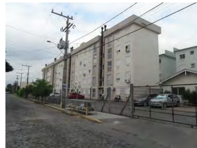
Figura 72 – Acesso ao conjunto e lixeiras
