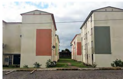
Figura 41 – Circulação entre os blocos
