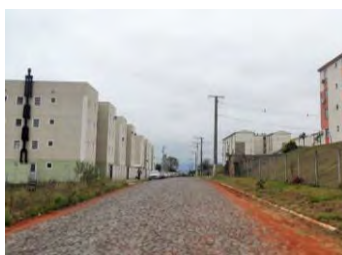
Figura 40 – Vista 3 - relação entre os edifícios
