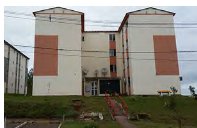
Figura 38 – Acesso aos blocos
