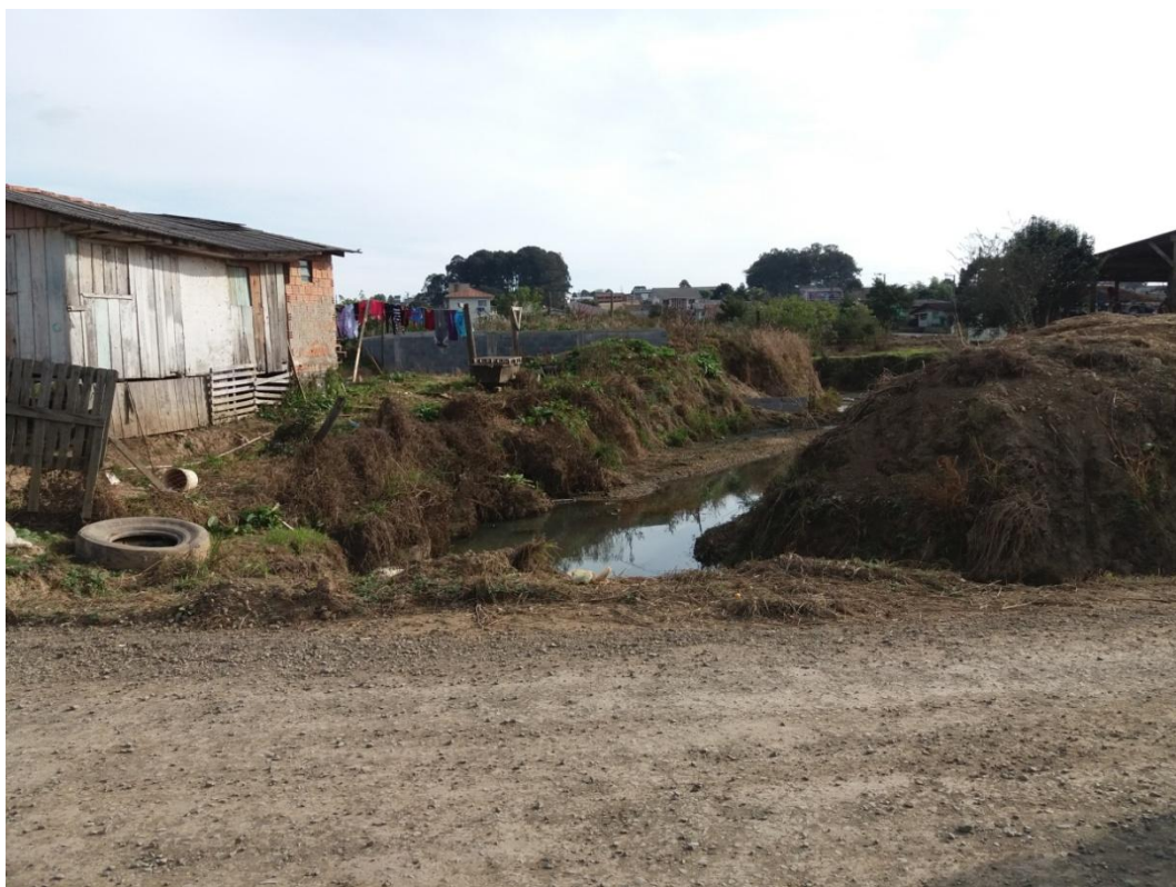
Figura 44: Área de Vulnerabilidade
