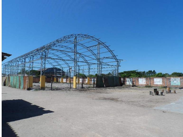
Foto 2 – Quadra Poliesportiva em obras
