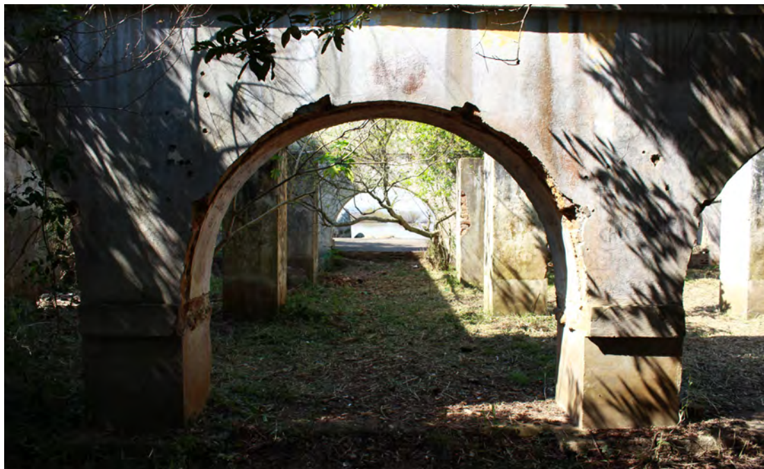
Porão da Casa da Guarda
