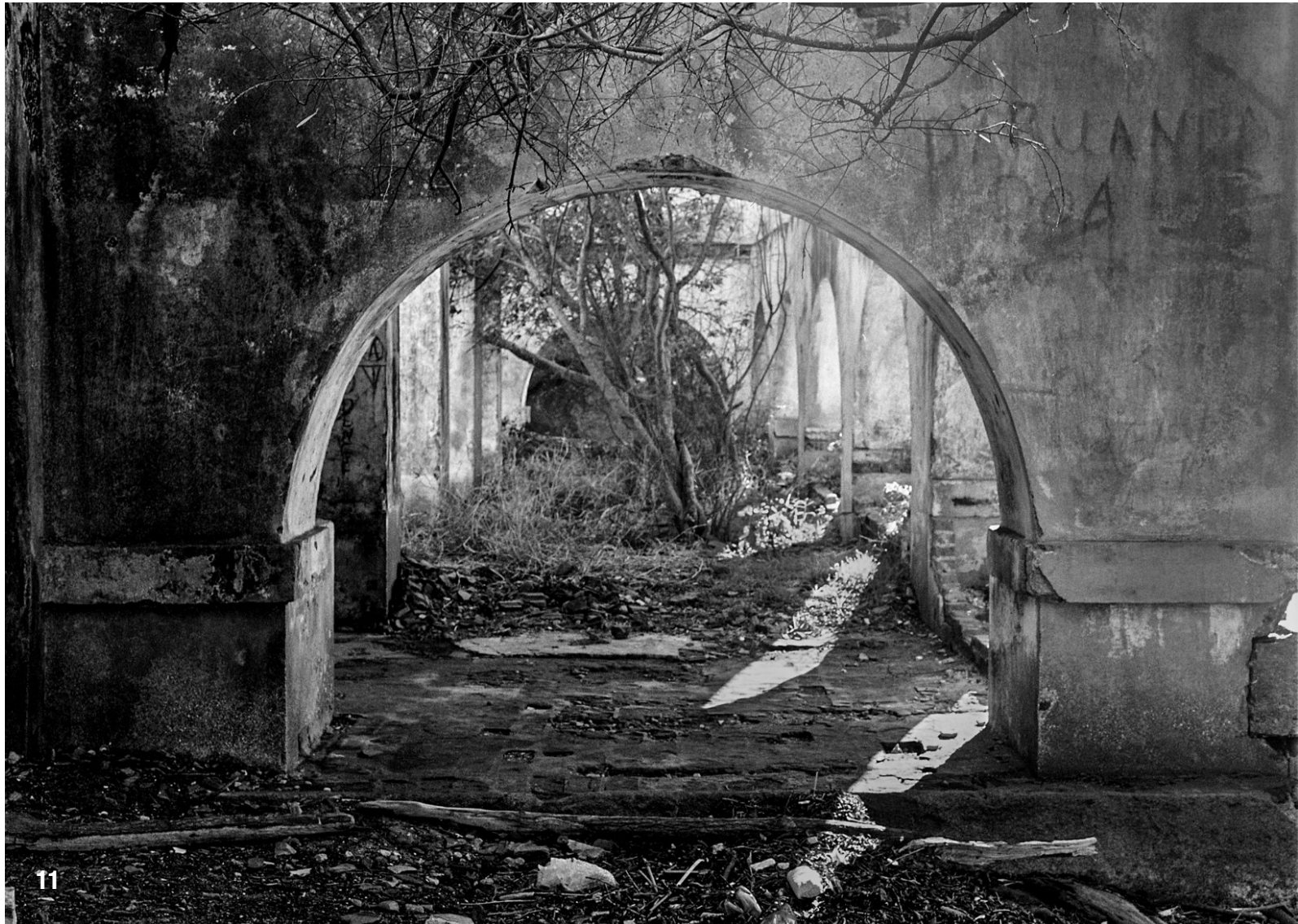
em cima Ruínas dos pilares do porão da Casa da Guarda
