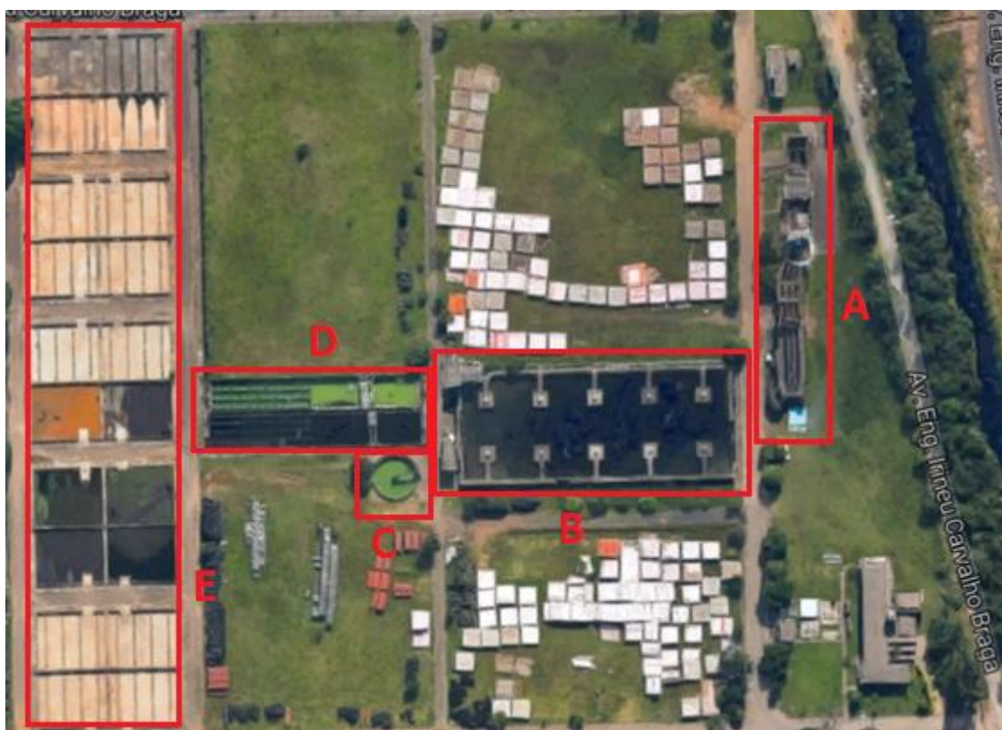
Figura 4. Vista aérea da Estação de Tratamento de Esgoto Mato Grande.
