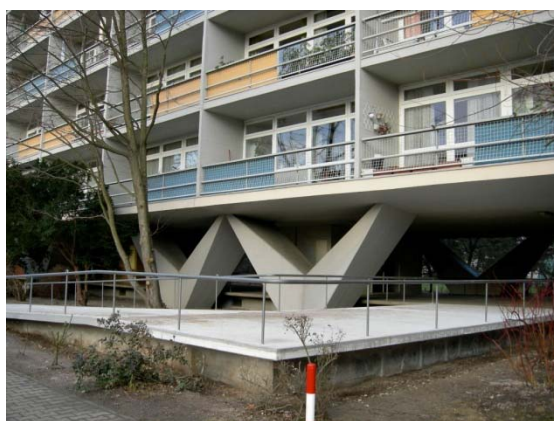
Vistas das fachadas oeste e leste e detalhe do pilares em "V".
