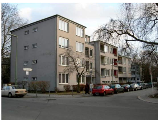
Vista da fachada oeste da barra de Max Taut. (Fotografias: Mara Oliveira Eskinazi)
