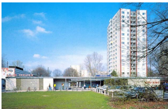
Centro comercial junto à Hansaplatz. (Fonte: DOLFF-BONEKÄMPER, Gabi e SCHMIDT, Franziska (1999). Das Hansaviertel - Internationale Nachkriegsmoderne in Berlin, pág. 50)
