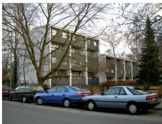
Vista da fachada oeste da barra de Kay Fisker. (Fotografia: Mara Oliveira Eskinazi)
