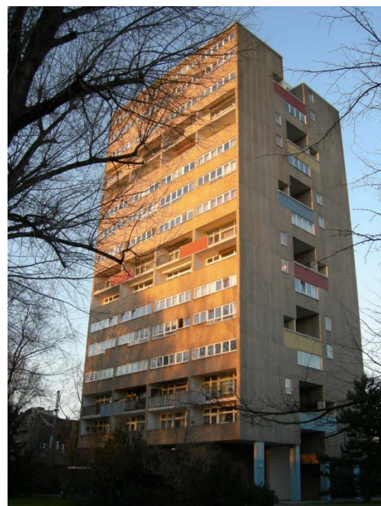
Fachadas oeste e sul da torre de Jacob Berend Bakema e Johannes Hendrik van den Broek. (Fotografia: Mara Oliveira Eskinazi)
