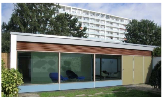
Planta das casas de Arne Jacobsen, duas vistas anteriores e uma posterior à reforma. (Fonte: Interbau Berlin 1957. Amtlicher Katalog der Internationalen Bauausstellung, pág. 133, e www.restaurierung-berlin.de )
