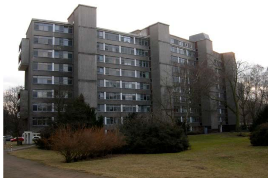
Fachadas sul e norte da barra de Walter Gropius. (Fotografia: Mara Oliveira Eskinazi)
