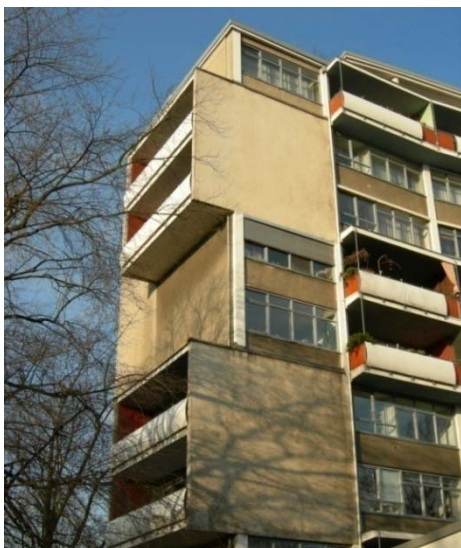
Detalhes da fachada sul da barra de Walter Gropius. (Fotografia: Mara Oliveira Eskinazi)
