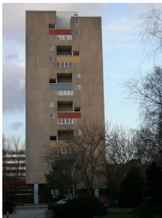
Fachadas leste e sul da torre de Jacob Berend Bakema e Johannes Hendrik van den Broek. (Fotografia: Mara Oliveira Eskinazi)
