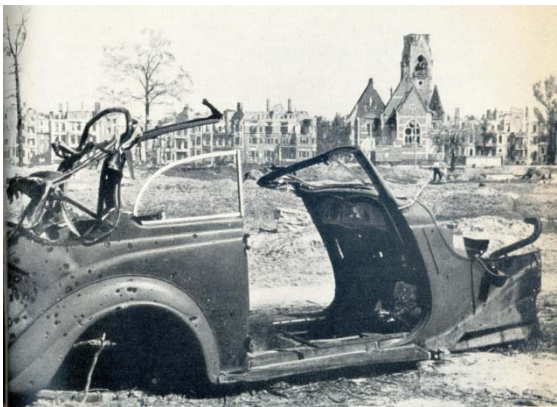
A destruição no Hansaviertel. (Fonte: Interbau Berlin 1957. Amtlicher Katalog der Internationalen Bauausstellung , pág. 335)
