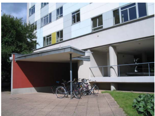
Fachada oeste, fachada leste e acesso junto à fachada leste da barra de Pierre Vago. (Fotografias: Mara Oliveira Eskinazi)
