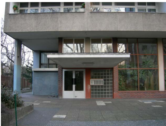
Vista do acesso na fachada oeste. (Fotografia: Mara Oliveira Eskinazi)
