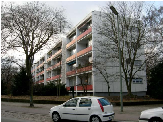
Vistas da fachada sul e da esquina das fachadas sul e leste da barra de Wassili Luckhardt e Hubert Hoffmann.
