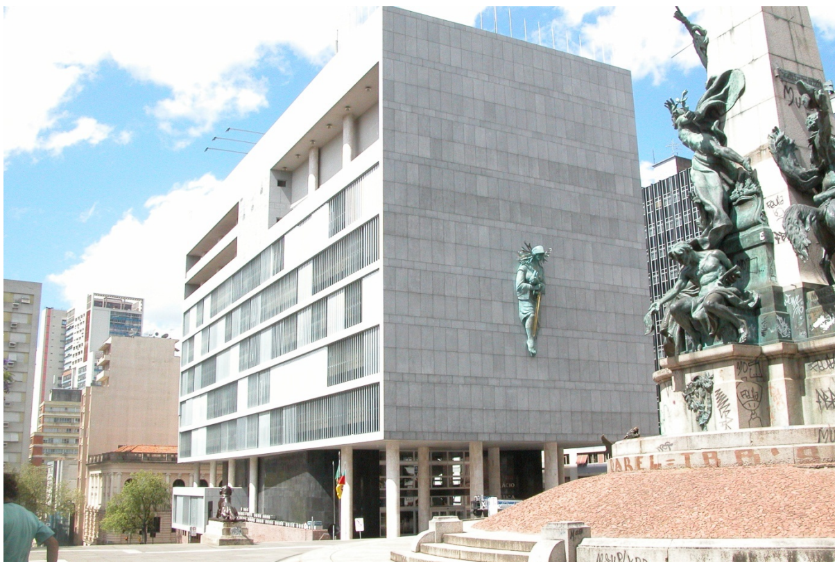
FIG. 251. Palácio da Justiça de Porto Alegre: revestimento de granito, escultura da Justiça, painéis murais na fachada Leste e na Oeste, quebra-sóis, terraços, os elementos, finalmente, estão presentes.
