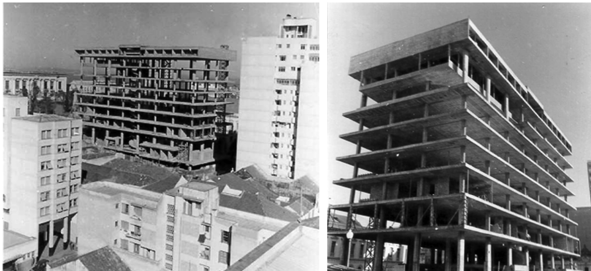
FIG. 83: Estrutura de concreto concluída, abril ou maio de 1957.
