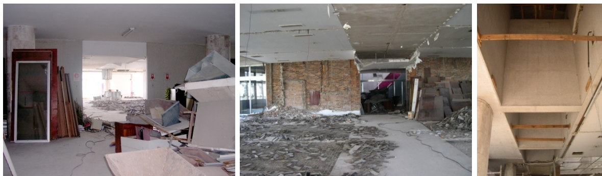
FIG. 197. Obras de demolição no 7º Pavimento para o retorno do restaurante, saguão, 12 de julho de 2003. FIG. 198. Obras de demolição no 7º Pavimento para o retorno do restaurante, ala norte, 12 de julho de 2003 FIG. 199. Obras de demolição no 7º Pavimento, retirada do forro pacote sob pergolado, 12 de julho de 2003.
