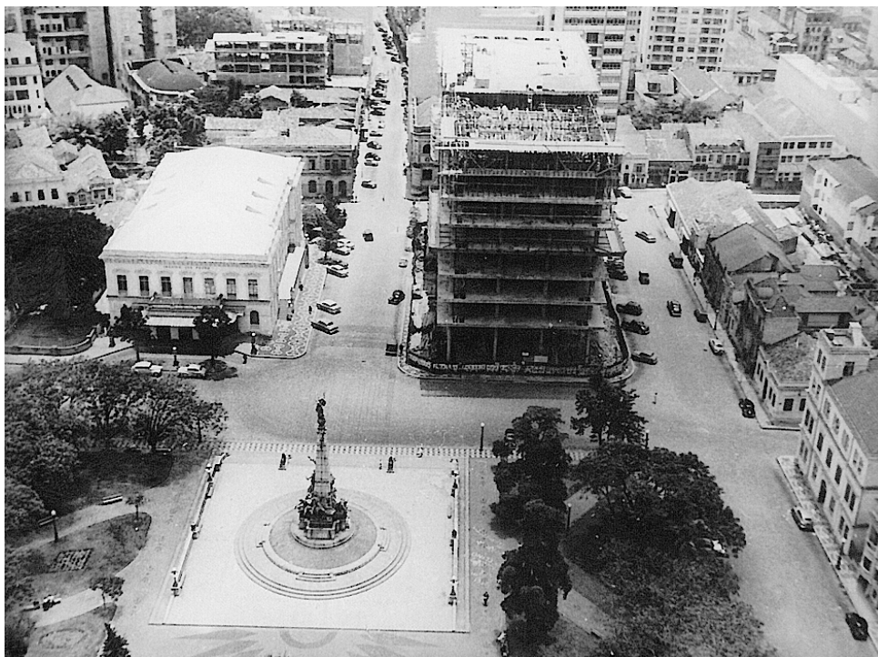
FIG. 82: Estrutura de concreto quase concluída, formas não retiradas, 1956.
