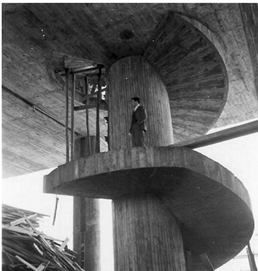
FIG. 73: arq. Luís Fernando Corona, patamar da escada no térreo, 19 de julho.
