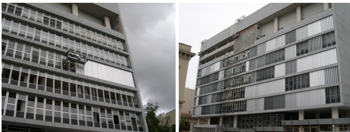
FIG. 209. Início da colocação dos quebra-sóis, fachada oeste, 14 de janeiro de 2004.
