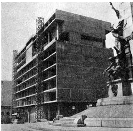
FIG. 85: execução dos serviços de alvenaria de tijolos, março de 1958.
