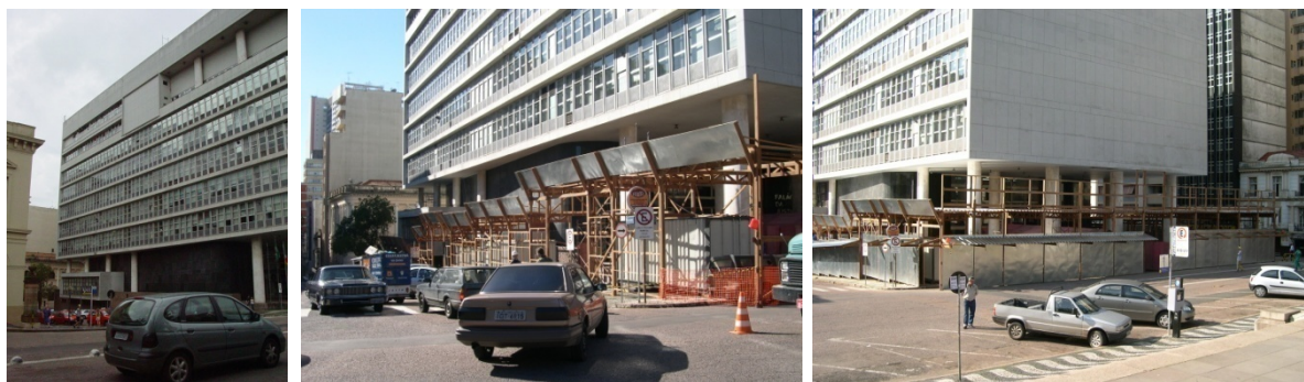
FIG. 203. Palácio antes do início das obras, fachada oeste, 7 de dezembro de 2002.
