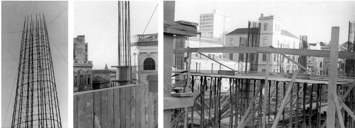
FIG. 59: armadura de pilar, abril de 1955.
