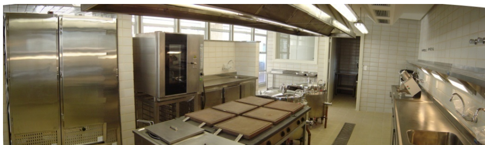
FIG. 218. Cozinha do restaurante, 7º pavimento, ala norte, julho de 2004.
