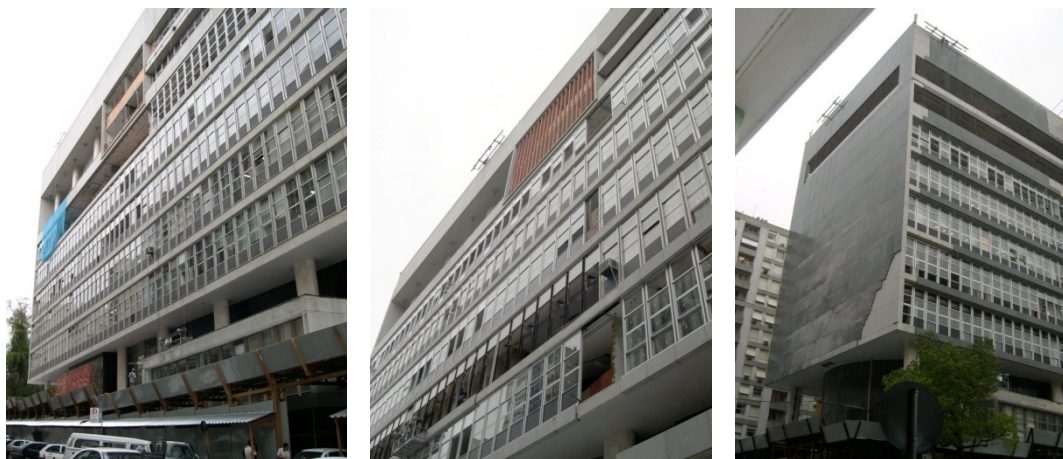
FIG. 206. Retirada das esquadrias existentes, fachada leste, 26 de setembro de 2003.
