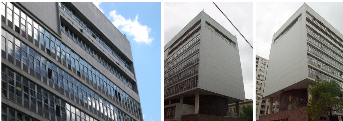
FIG. 156. Fachada Leste, esquadrias fechando terraços do 6º e 7º pavimento e painel lateral sem relevos, 2002. FIG. 157. Esquina mostrando fachada leste e fachada norte, esquadrias fechando terraços do restaurante, 2002 FIG. 158. Esquina mostrando fachada norte e fachada oeste, terraços fechados e ausência de quebra-sóis, 2002
