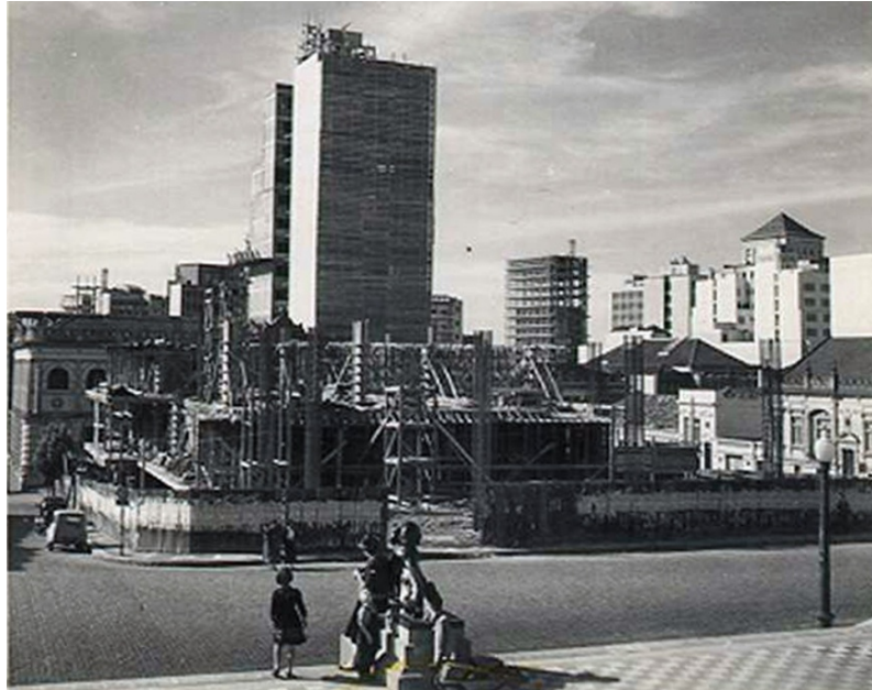
FIG. 66: formas das lajes da galeria e armadura do pilotis visíveis para os pedestres, abril de 1955.
