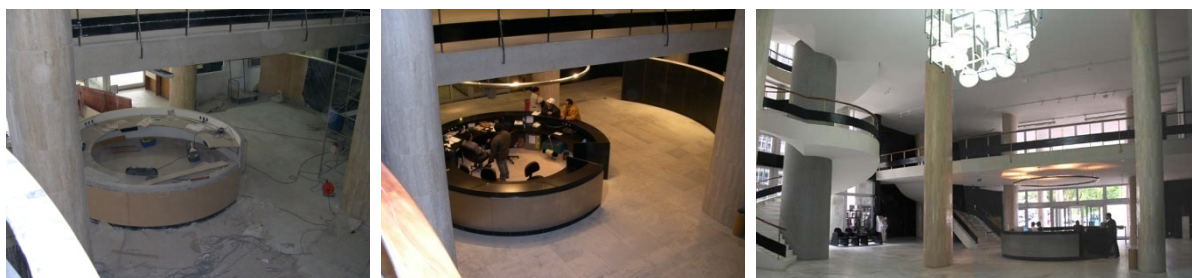
FIG. 226. Saguão do térreo em obras, 8 de abril de 2004
