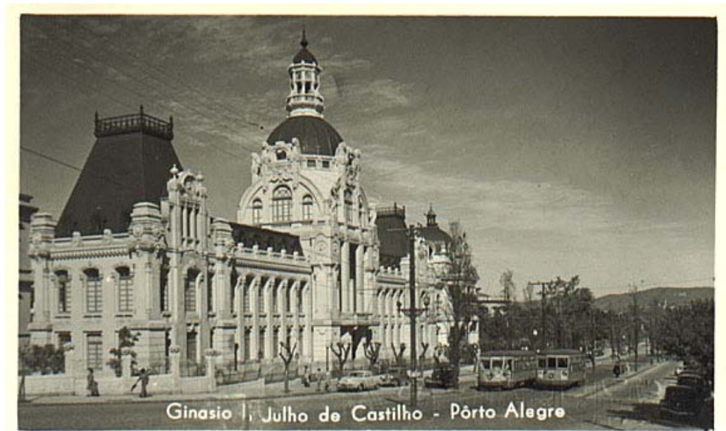
FIG. 15: Colégio Estadual Júlio de Castilhos, entre os prédios da Escola de Engenharia e Direito.
