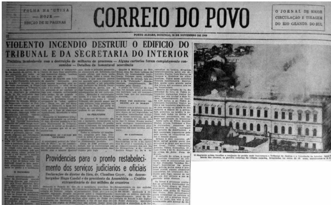
FIG. 8: Incêndio do Tribunal de Justiça, 19 de novembro de 1949
