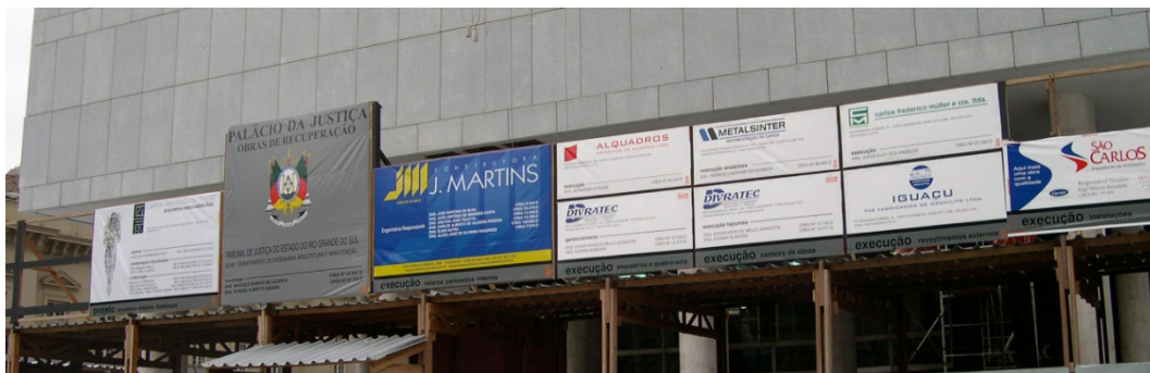
FIG. 248. Placas de obra das empresas envolvidas, outubro de 2003
