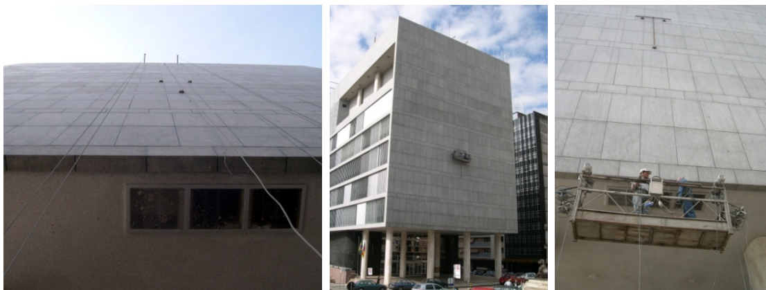
FIG. 231. Teste de alinhamento dos 3 apoios para escultura, 1º de outubro de 2005. FIG. 232. Arquiteto Fayet posicionando o gabarito nos apoios, 1º de outubro de 2005 FIG. 233. Carlos M. Fayet descendo após colocar o gabarito, 1º de outubro de 2005.
