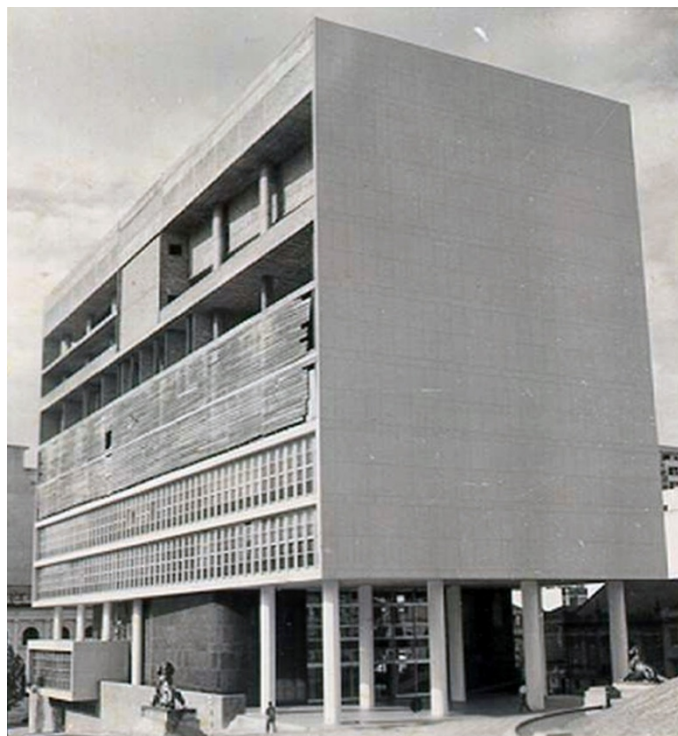
FIG. 96: O Palácio visto da Praça da Matriz, esquadrias colocadas até o 2º pavimento, pastilhas cerâmicas aplicadas na fachada sul, 1962.
