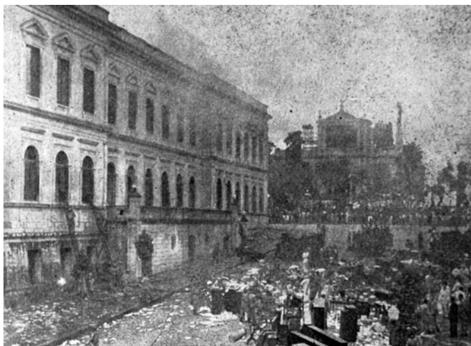
FIG. 9: Incêndio do Tribunal de Justiça, 19 de novembro de 1949.
