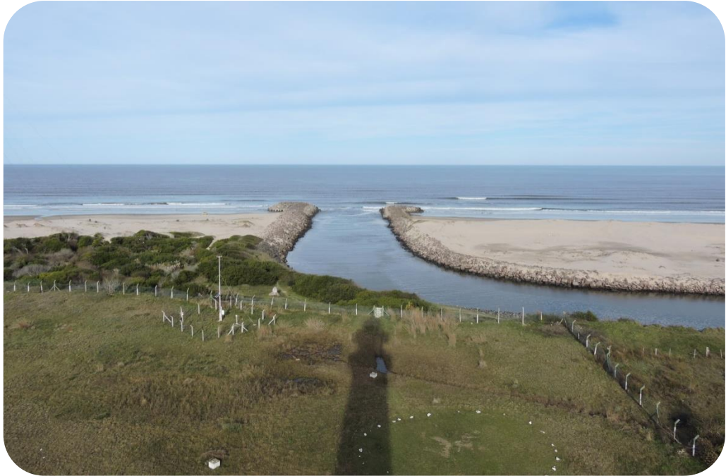
Figura 10. Configuração atual da desembocadura do Arroio Chuí. Arquivo pessoal, 2016.
