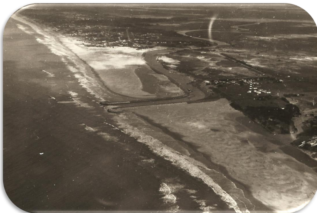
Figura 21. Vista aérea do norte para o sul da desembocadura do Arroio Chuí após a fixação da barra. Retirado de Portobrás (1978).
