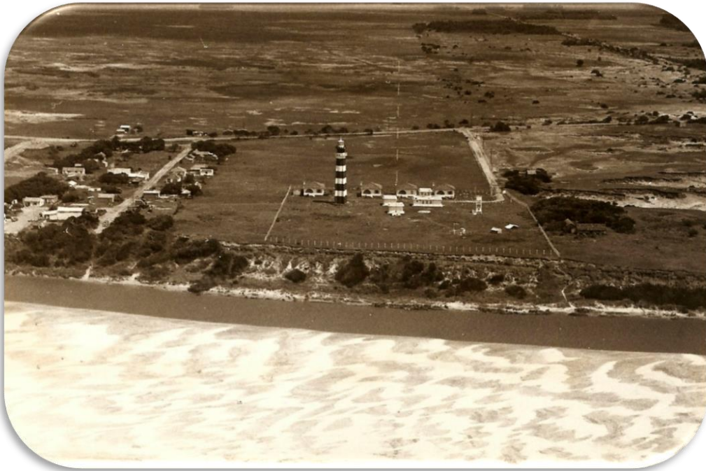
Figura 4. Vista aérea da barra móvel em frente ao Farol Stella Maris. A barra foi fixada posteriormente no ponto definido pela interseção da linha que parte do farol em direção perpendicular à linha geral da costa. Retirado de Portobrás (1976).
