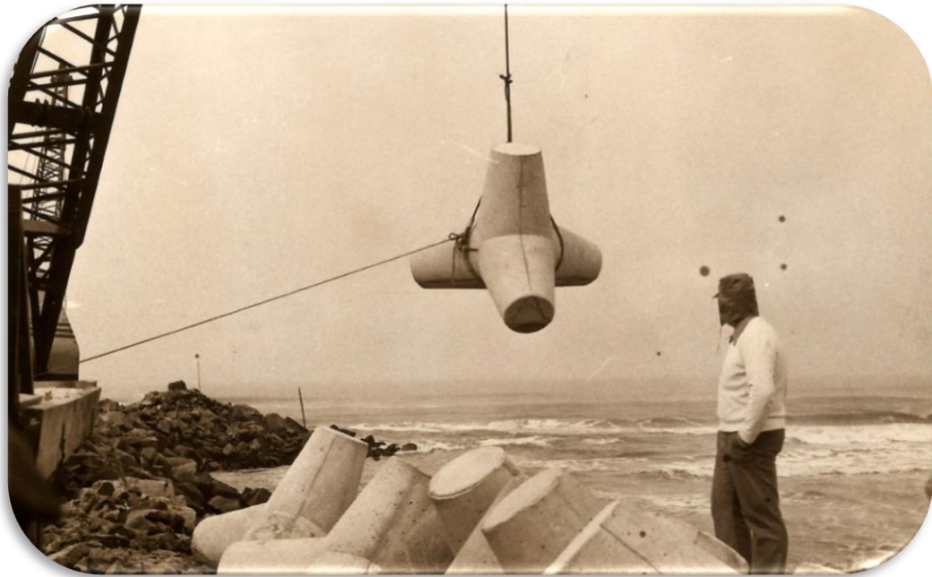
Figura 8. Colocação de tetrápode no paramento externo do molhe uruguaio. Retirado de Portobrás (1978a).
