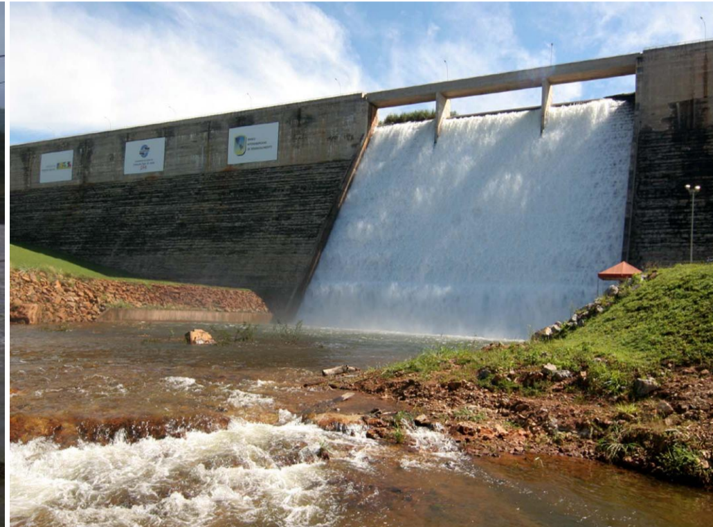
Vertedouro em Degraus da Barragem João Leite - Estado de Goiás
