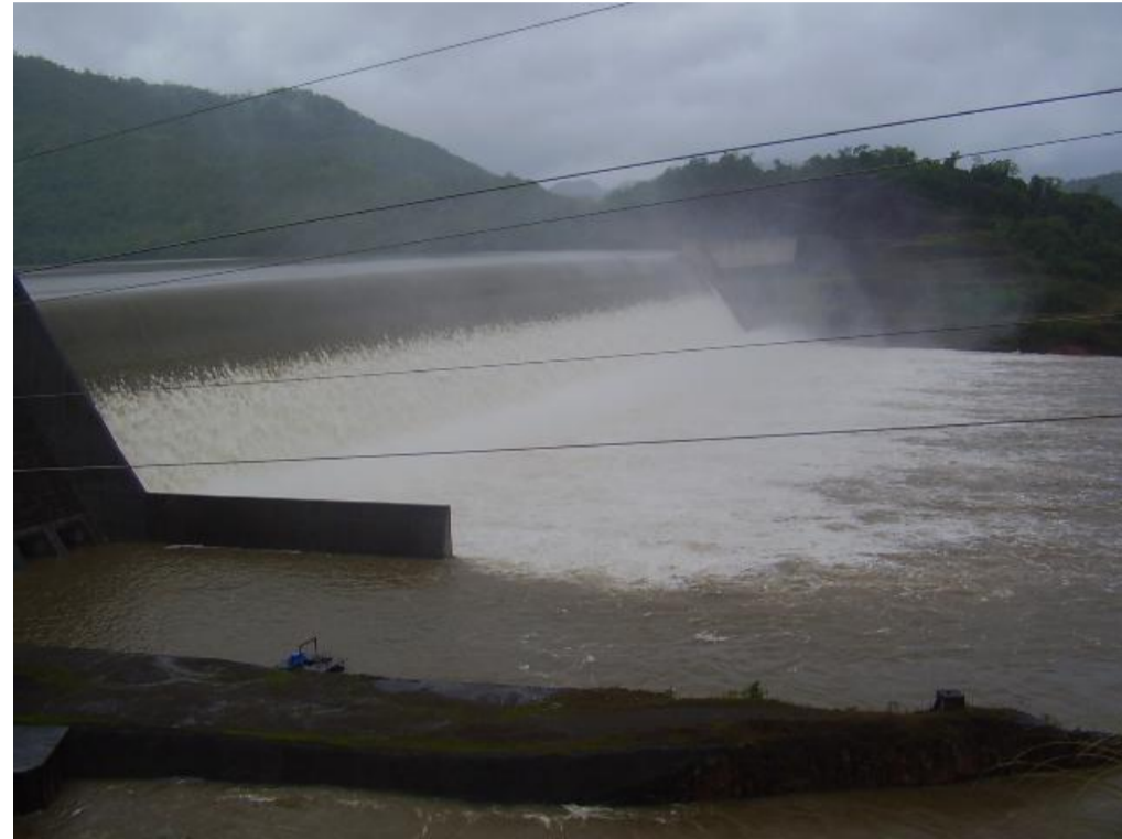
Vertedouro em Degraus da UHE Dona Francisca - Agudo/RS
