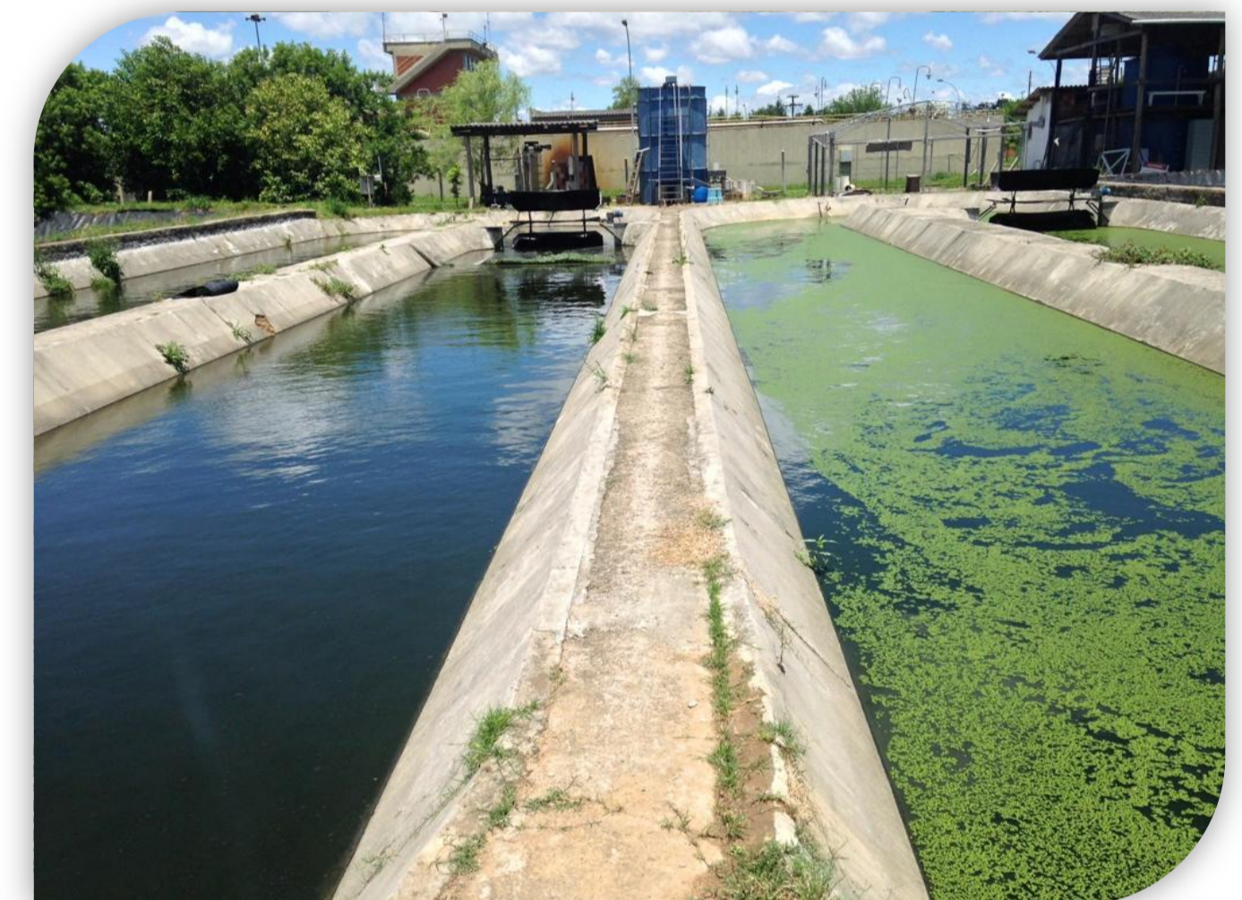
Figura 2 - Reator UASB (fundo), LAT-M (direita) e LAT-A (esquerda).
