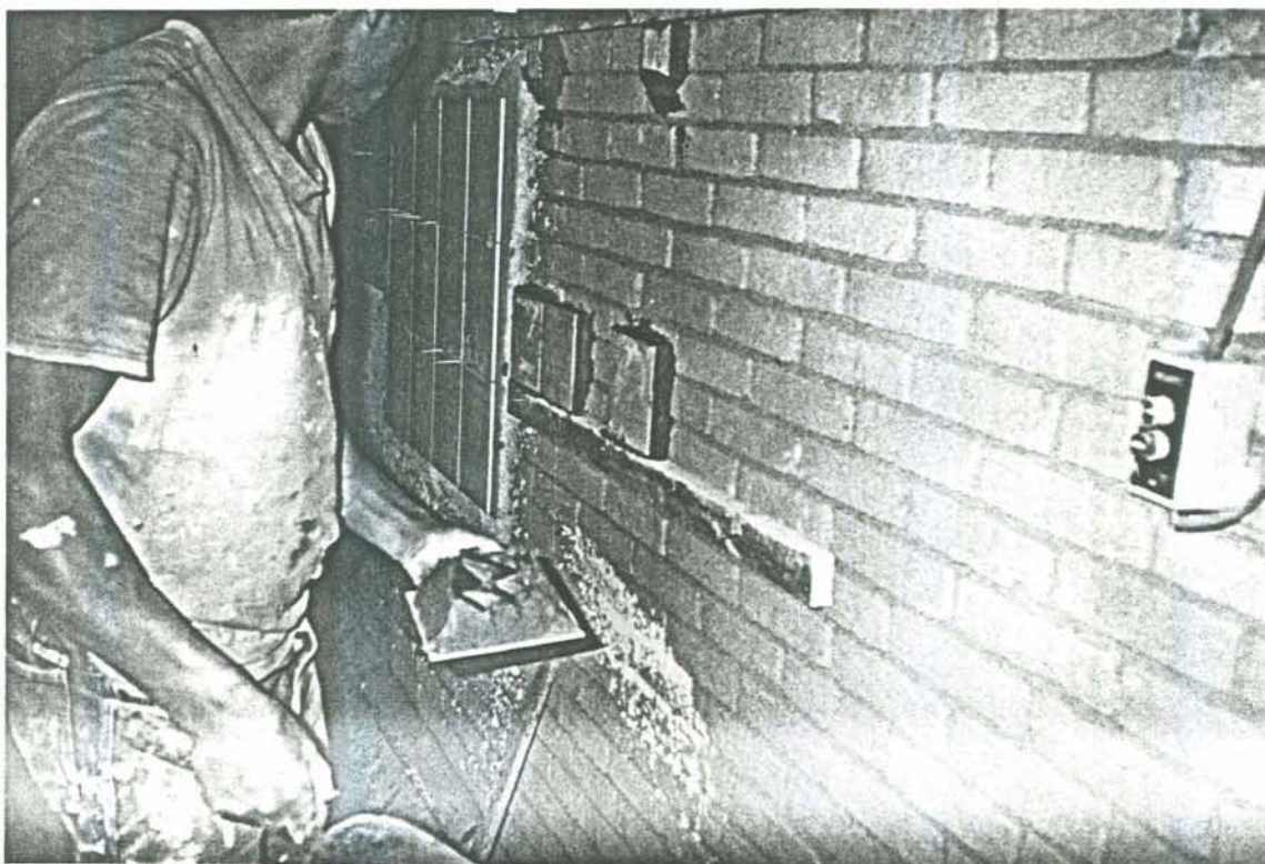
FOTO 4.11- Colocação da porção de argamassa de assentamento sobre a face não vidrada do azulejo (tardoz).
