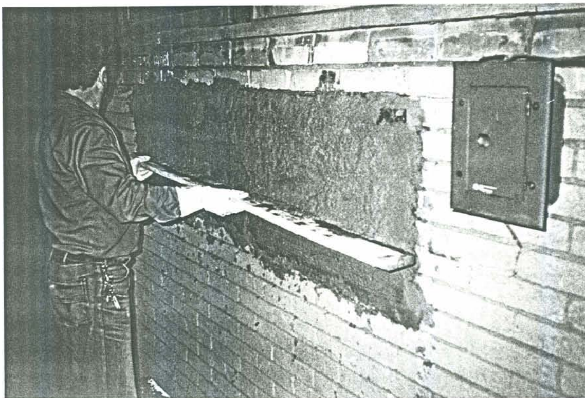
FOTO 4.7- Execução da camada de regularização.
