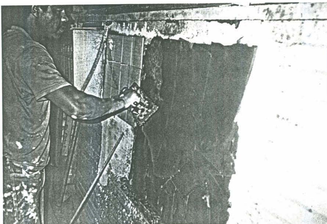
FOTO 4.9- Azulejista estendendo a argamassa adesiva à base de cimento.
