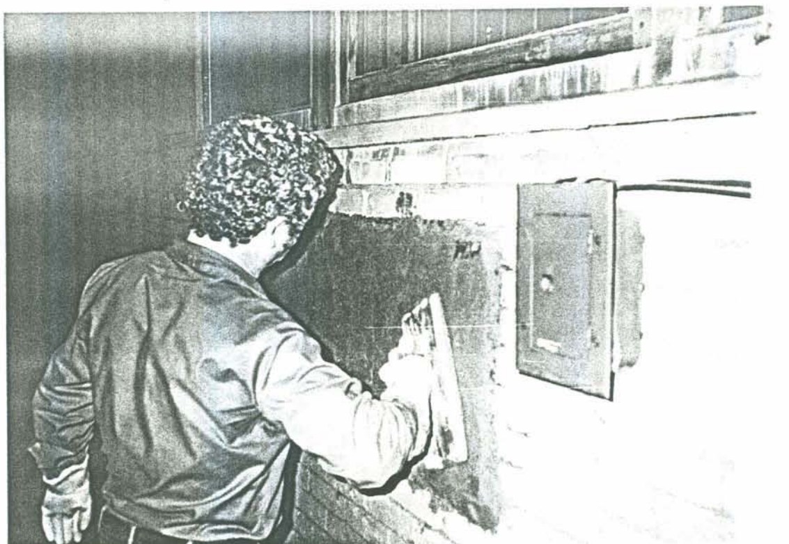
FOTO 4.8- Execução da camada de regularização- desempenamento.
