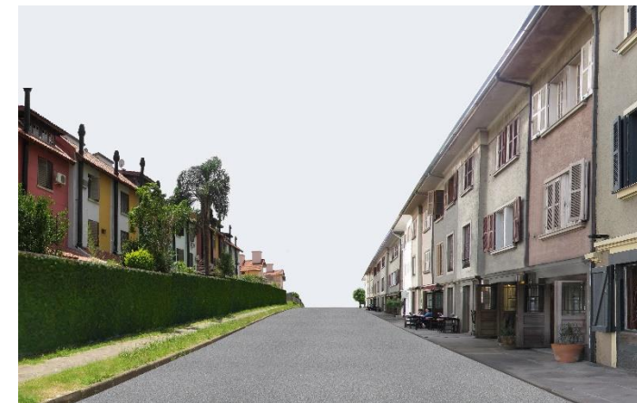
Figura 5 – Rua com muros com vegetação em um lado
