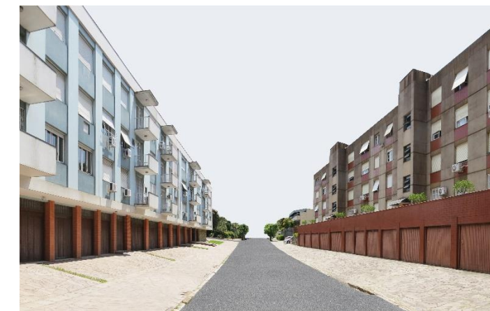
Figura 6 – Rua com garagens em ambos lados
