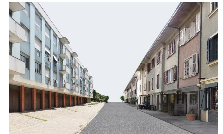
Figura 7 – Rua com garagens em ambos lados
