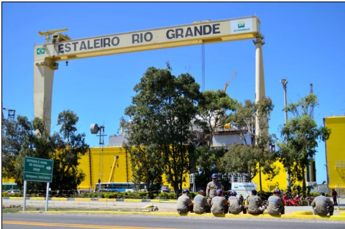
IMG 2 - Trabalhadores ECOVIX em frente ao pórtico
