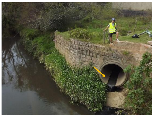
Vazão de tempo seco lançada próximo ao pontilhão da Av. Juca Batista.
