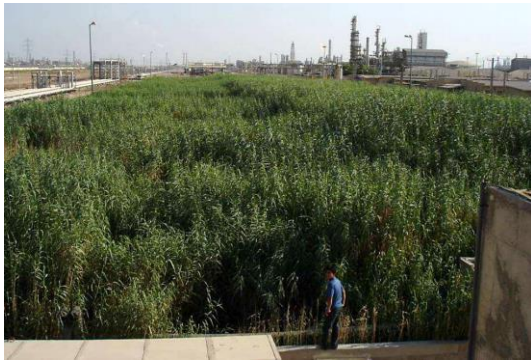
Banhado construído para tratamento de efluentes em planta industrial, Irã.
