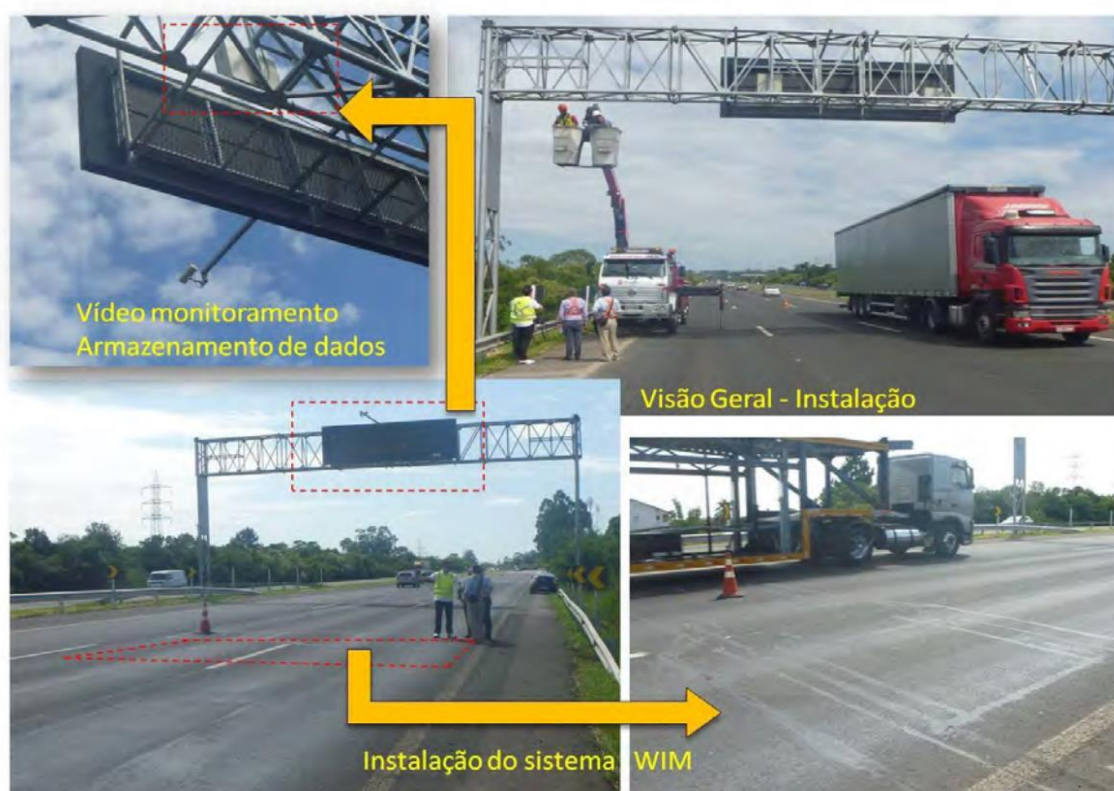
Figura 51 – Local de instalação do sistema de pesagem em movimento
