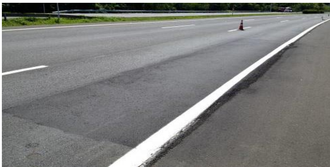
Figura 94 – Remendo superficial executado no trecho monitorado 1 da BR-290/RS após intensas chuvas (km 14+400) (Adaptado de Mattos, 2014)
