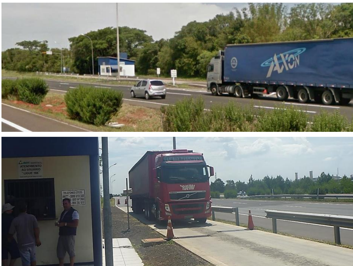
Figura 43 – Localização, infraestrutura e operação do PPVM do km 65 PS da BR-290/RS
