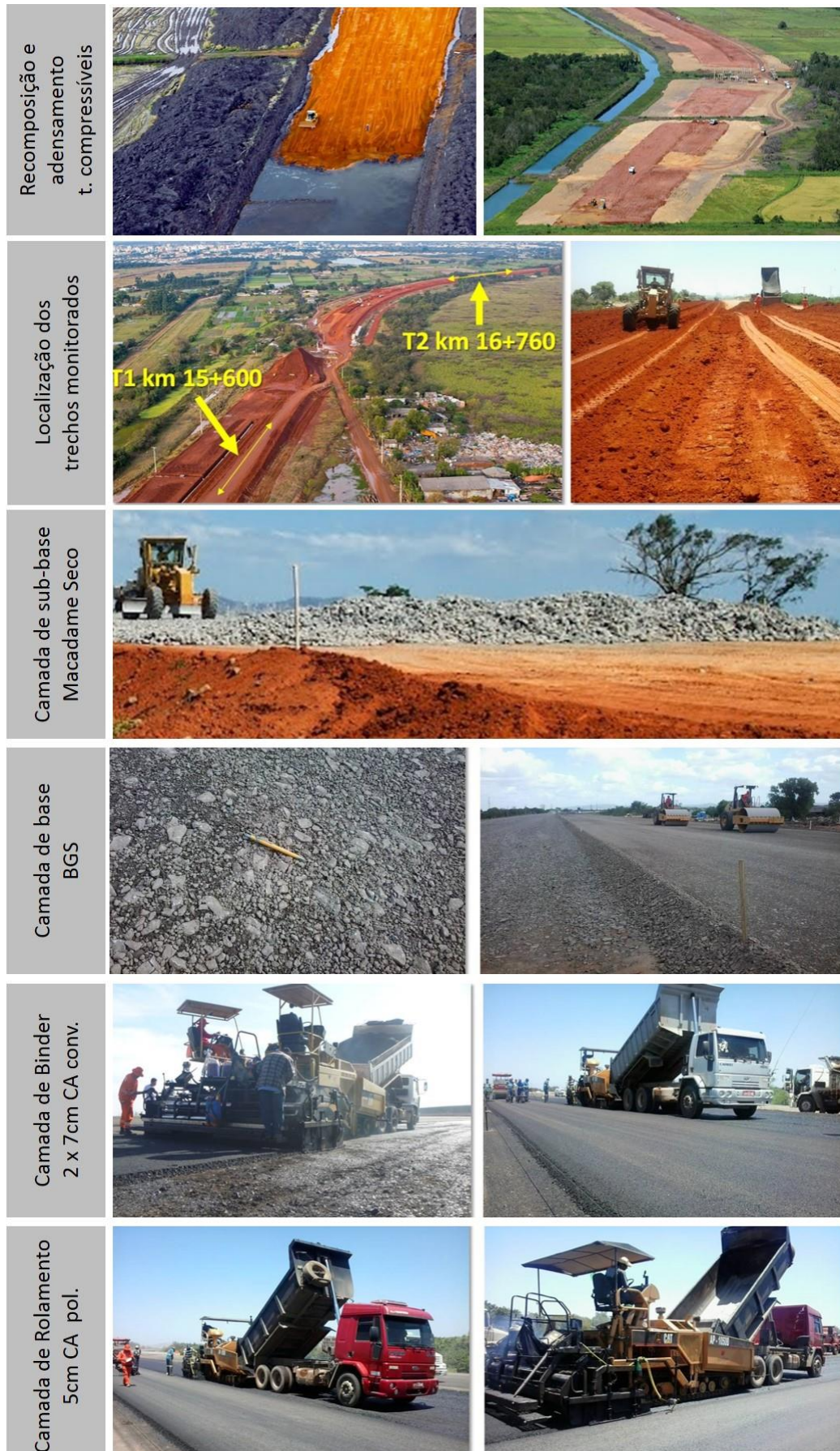
Figura 30 – Sequência de execução da estrutura do pavimento da BR-448/RS
