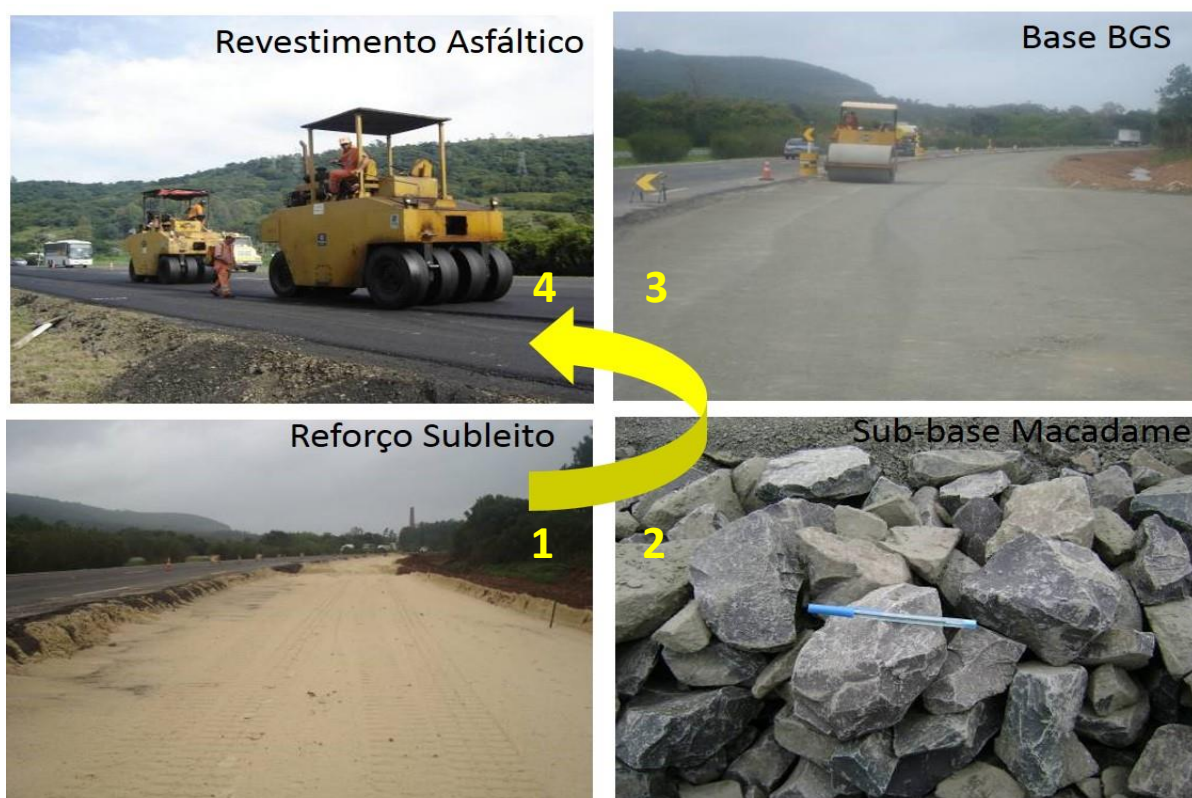
Figura 25 – Principais etapas de execução dos trechos experimentais da BR-290/RS. Adaptado de Mattos (2014)
