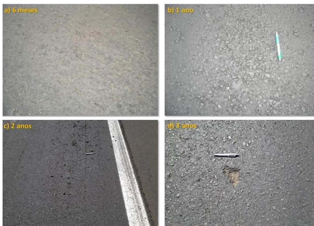
Figura 93 – Evolução dos defeitos superficiais durante o período de monitoramento dos trechos experimentais da BR-290/RS (Adaptado de Mattos, 2014)
