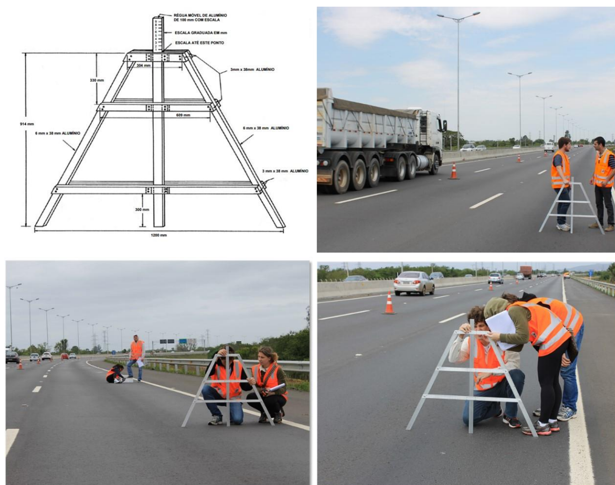
Figura 35 – Ensaio para verificação de Afundamento de Trilha de Roda (ATR)
