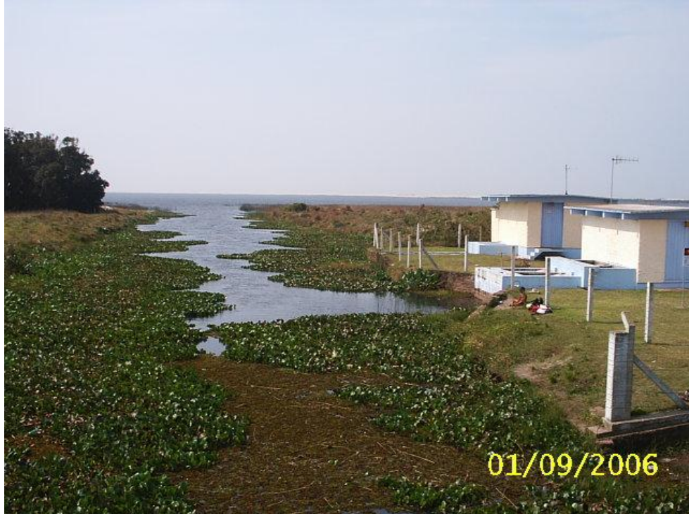
Figura 8 – Imagem da RS-784: canal de captação de água bruta, à direita abrigos dos conjuntos moto-bombas novo e antigo e ao fundo Lagoa da Fortaleza .
