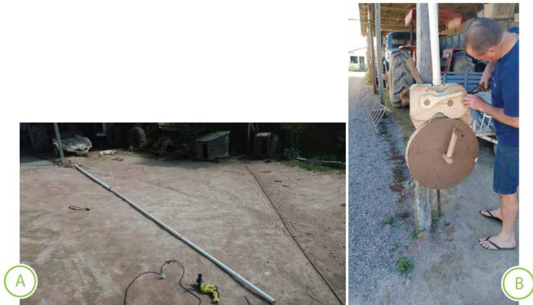
Figura 55 – Instalação para teste: (A) Seções da antena dispostas para instalação e (B) Modelo 03 de mecanismo sendo fixado em uma coluna de apoio.
