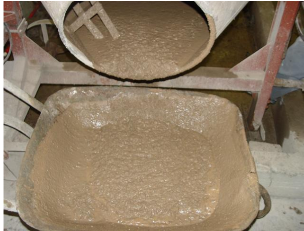
Figura 4.23: transporte do concreto auto-adensável.
