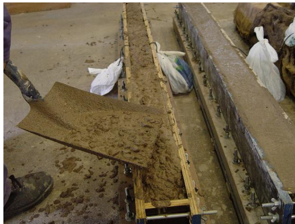
Figura 4.24: moldagem das vigas com concreto auto-adensável.
