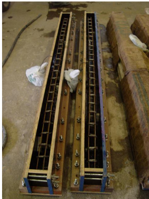
Figura 4.22: vigas prontas para serem moldadas.
