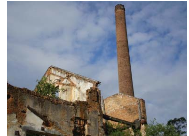
vista das ruínas da Fábrica de Papel
