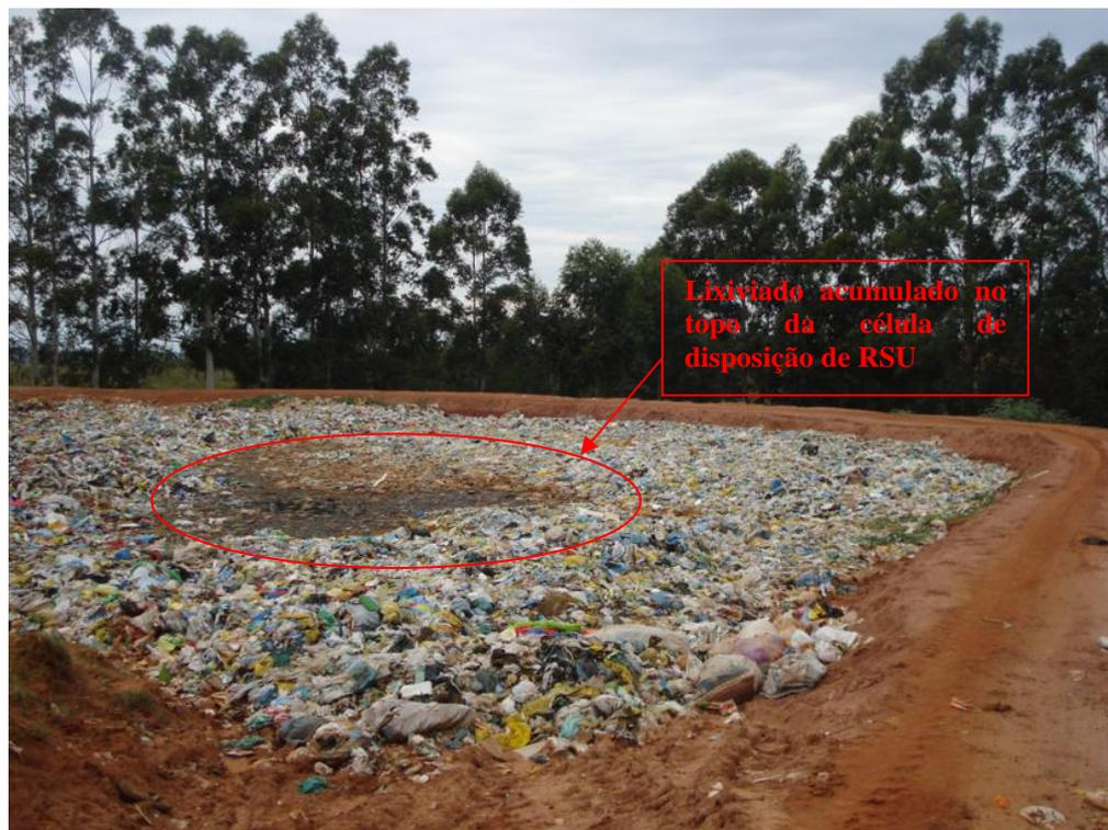
Figura 27: Célula de aterro controlado sem cobertura, sem drenagem de gases e com problemas na drenagem de lixiviado.
