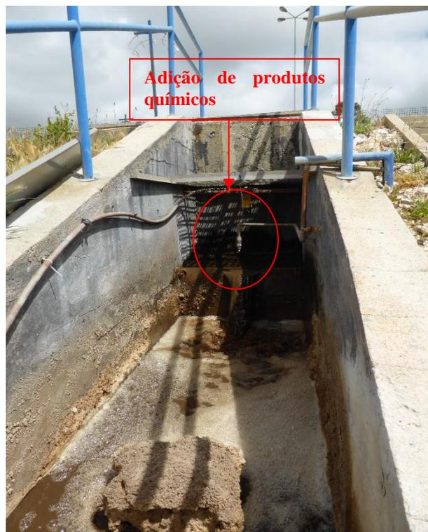
Figura 45: Passagem entre as lagoas aeradas e o decantador onde ocorre a adição de produtos químicos
