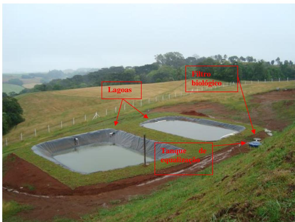
Figura 28: Tratamento de efluentes contendo tanque de equalização, filtros biológicos e lagoas
