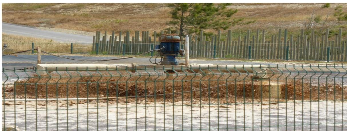
Figura 43: Lagoa de aeração da ETL com aeradores em funcionamento
