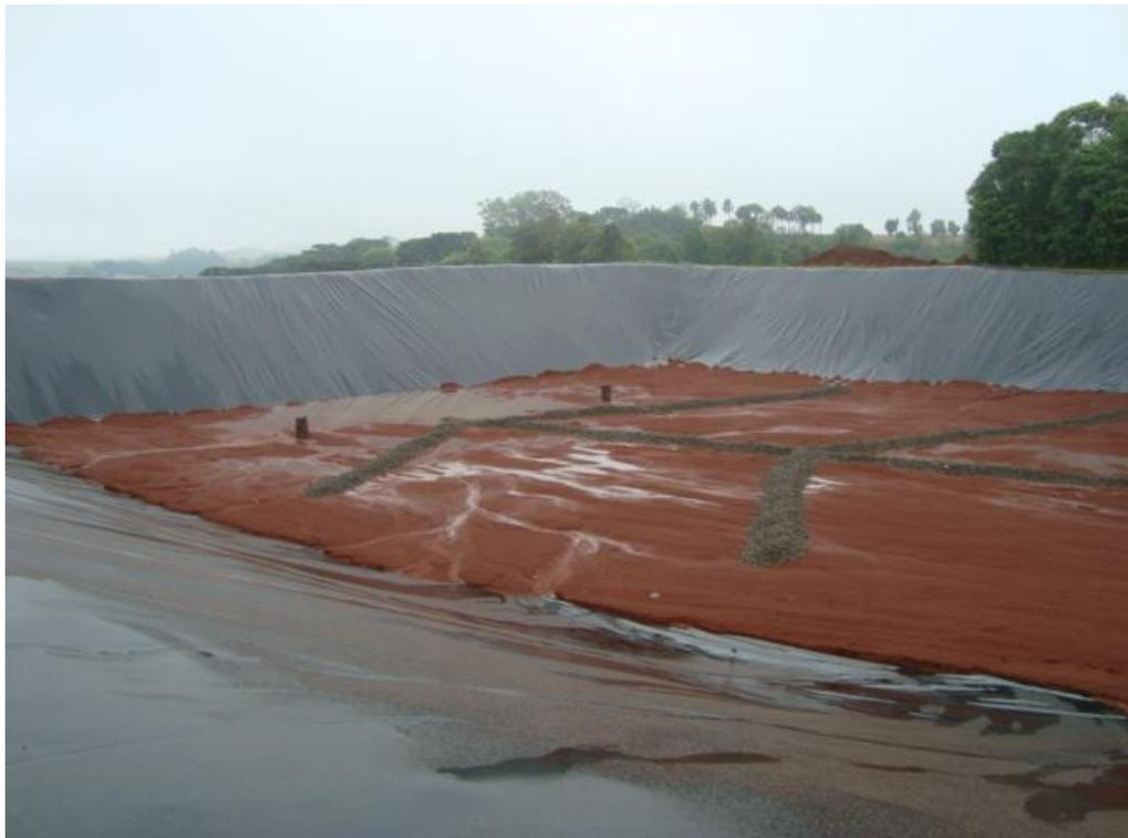
Figura 25: Detalhe de drenagem de lixiviado em formato espinha de peixe antes da operação da célula em aterro sanitário
