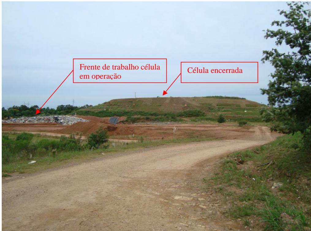
Figura 22: Célula de aterro sanitário em operação e encerrado
