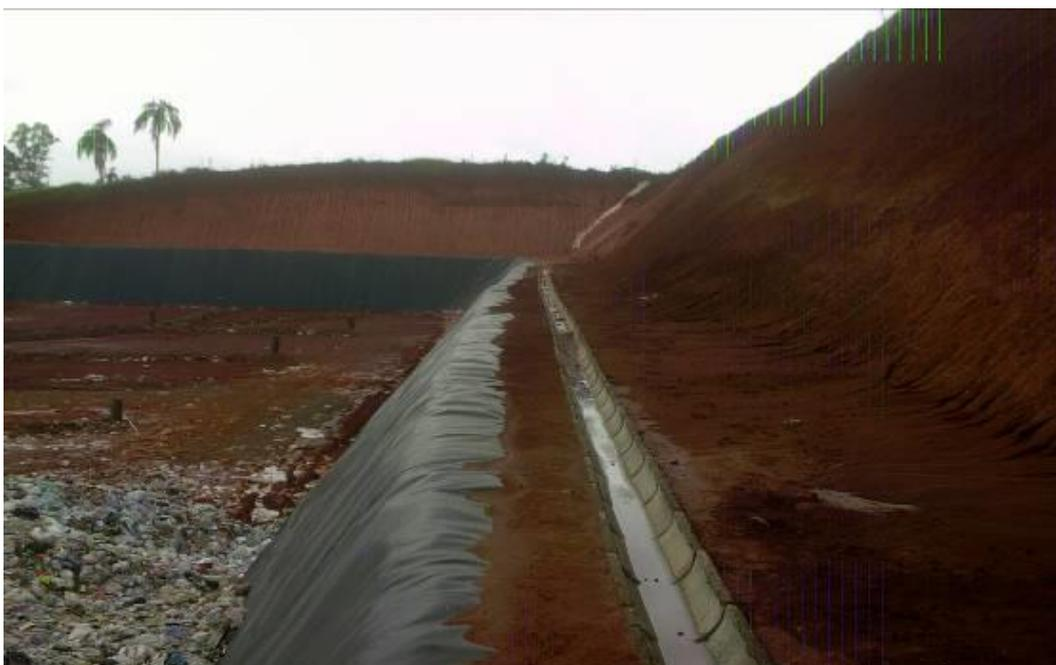
Figura 26: Detalhe da drenagem pluvial no entorno da célula de disposição de RSU
