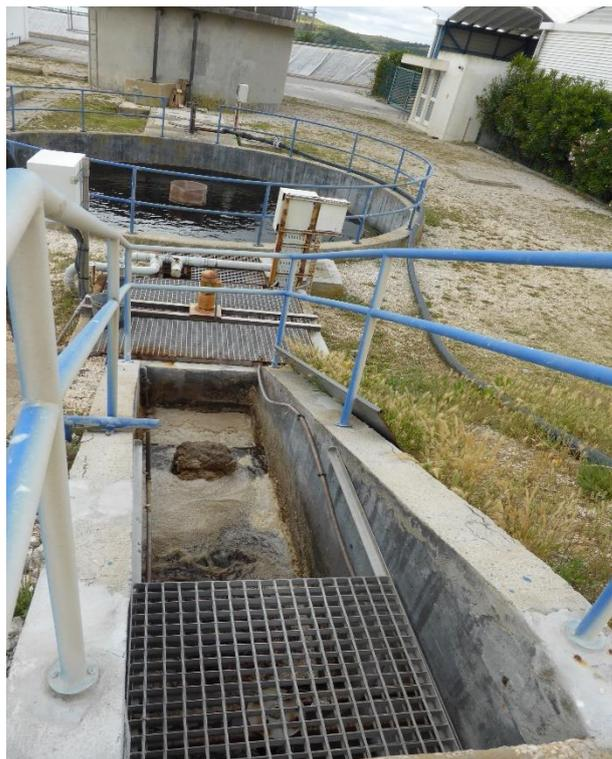
Figura 44: Passagem entre as lagoas aeradas e o decantador
