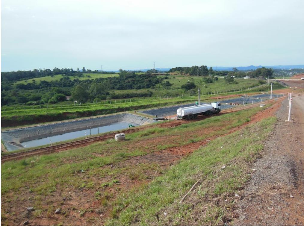
Figura 29: Sistema de acúmulo de lixiviado por lagoas
