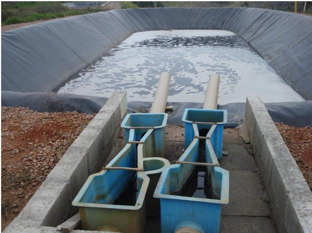
Figura 30: Medidor de vazão, tipo calha parshall, na entrada do sistema
