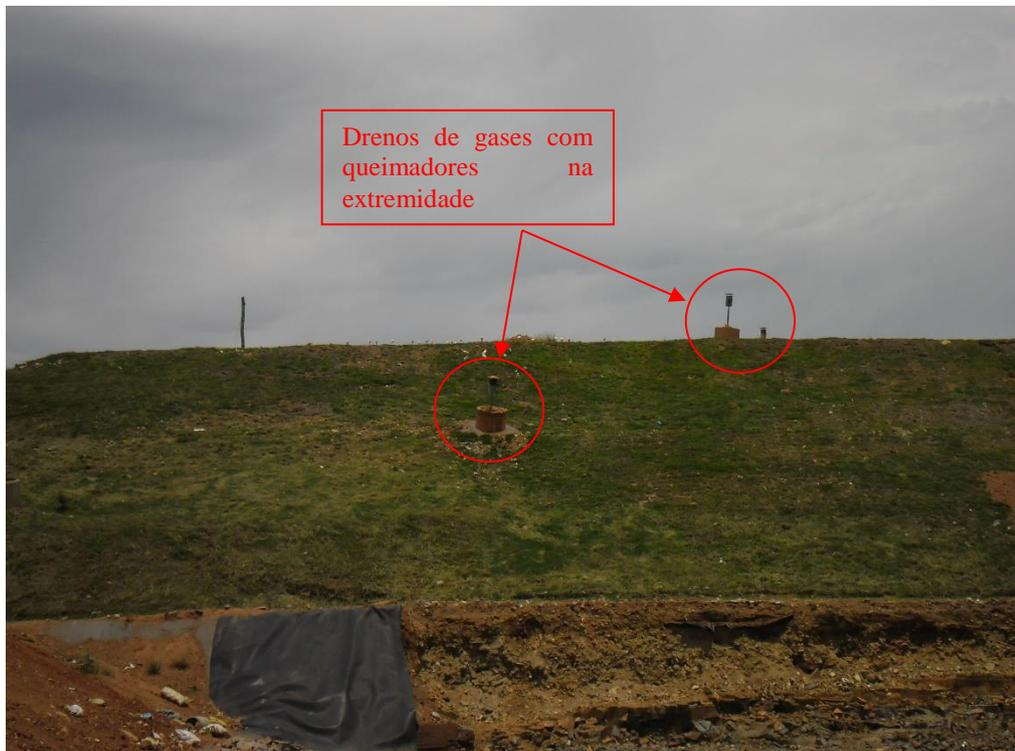
Figura 23: Célula de aterro sanitário encerrada
