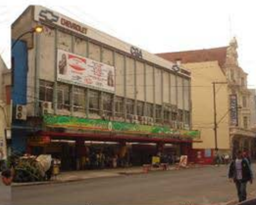
08.ANTIGA CGA-ÁREA DE INTERVENÇÃO
