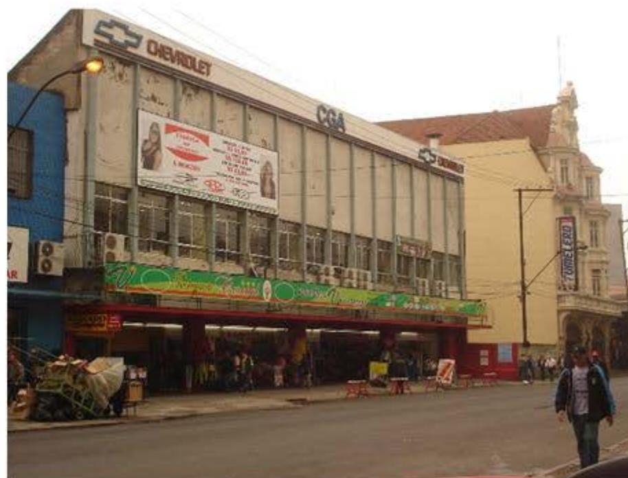
ANTIGA CHEVROLET QUE SERÁ DEMOLIDA E AO FUNDO O EDIFÍCIO ELY
