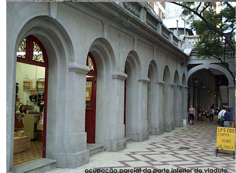
ocupação parcial da parte inferior do viaduto
