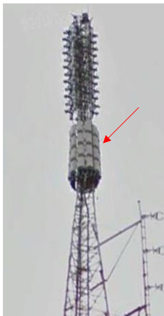
Figura 24: Painéis de dipolos da Geradora de Florianópolis/SC
