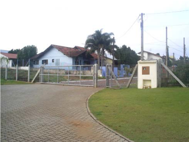
Fig. 19 – Vista interna do Acesso Secundário - Rua Antonio Kolling
