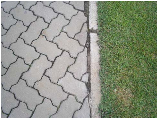
Fig. 27 – Pavimentação executada na primeira fase
