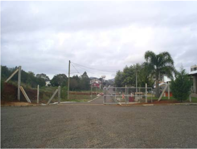
Fig. 17 – Vista interna do Acesso Secundário - Rua Arno Nienow
