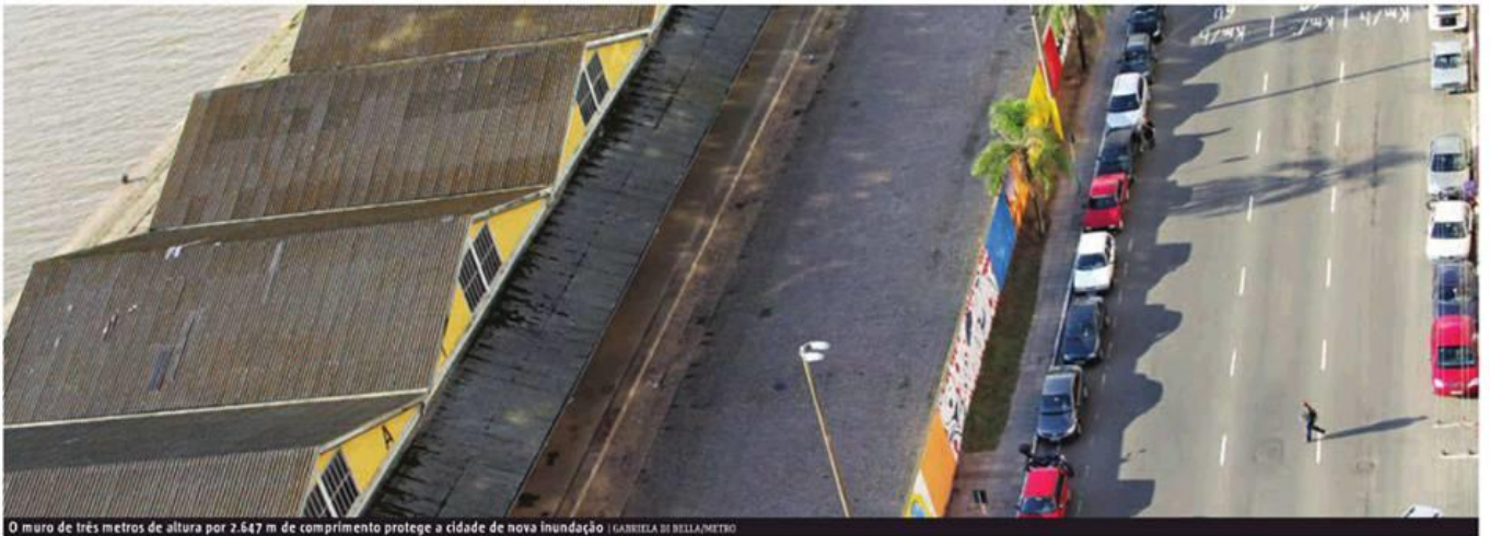
O muro de três metros de altura por 2.547 m de comprimento protege a cidade de nova inundação | GABRIELA DE BELLA/METRÔ
