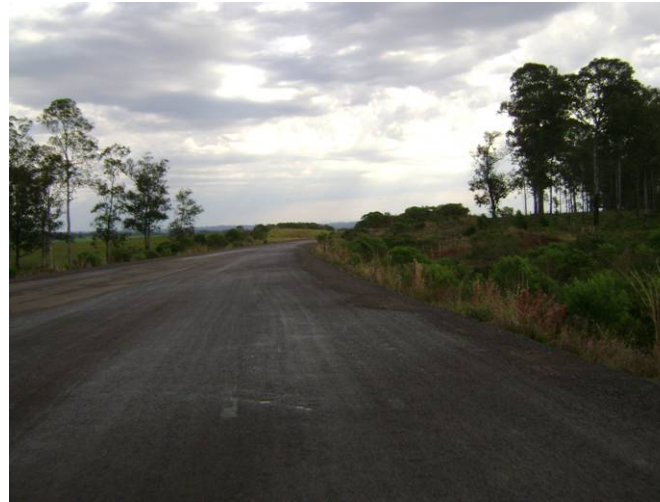
Acesso ao terreno - RS 471
