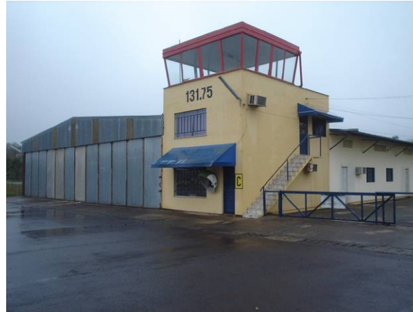
Hangar 1 e torre de controle
