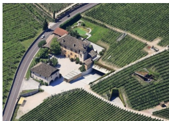
Vinícola Manincor Caldaro, Itália Implantação de modernas instalações mantendo a antiga paisagem do local
