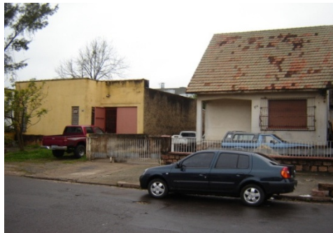
4. Terrenos lindeiros – com a compra do lote a casa da esquerda seria demolida.
