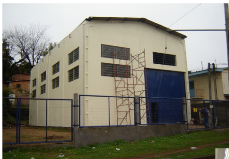
Nova sede - em construção
