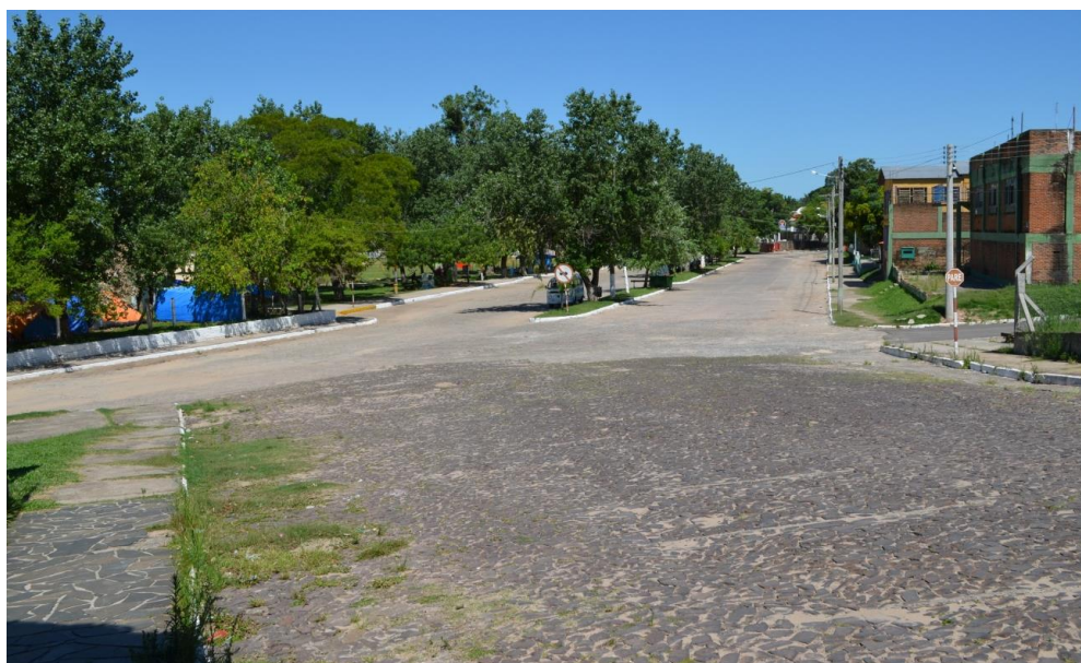
Figura 58: Avenida das Areias Brancas em Rosário do Sul. (Fonte: autor, janeiro de 2013).
